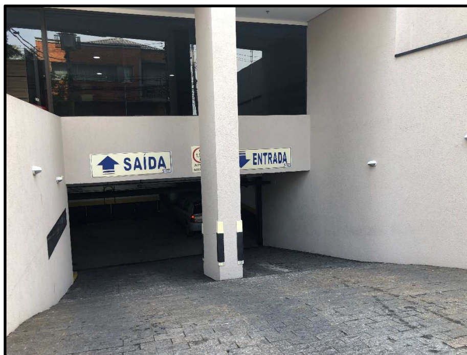
Foto 4 – “THE OFFICE BROKFIELD” – entrada do estacionamento
