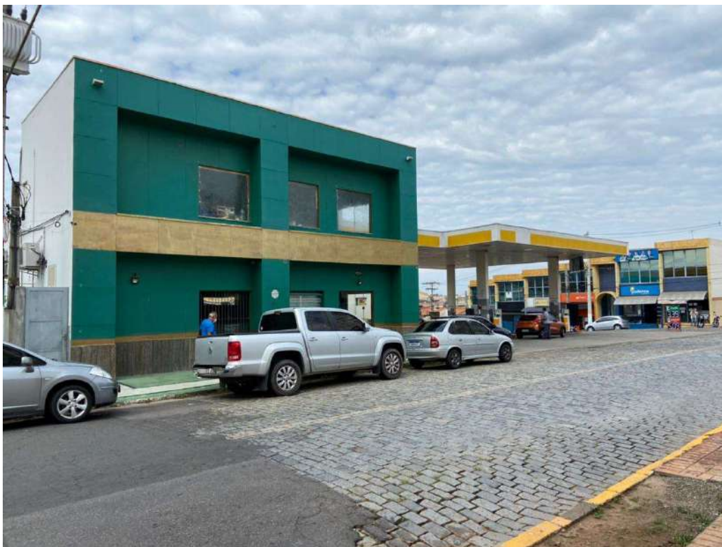
FACHADA LATERAL DO IMÓVEL
