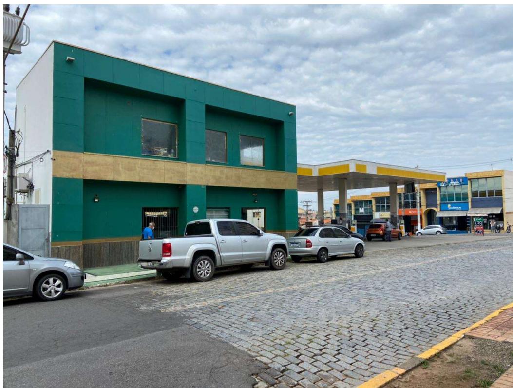
FACHADA LATERAL DO IMÓVEL
