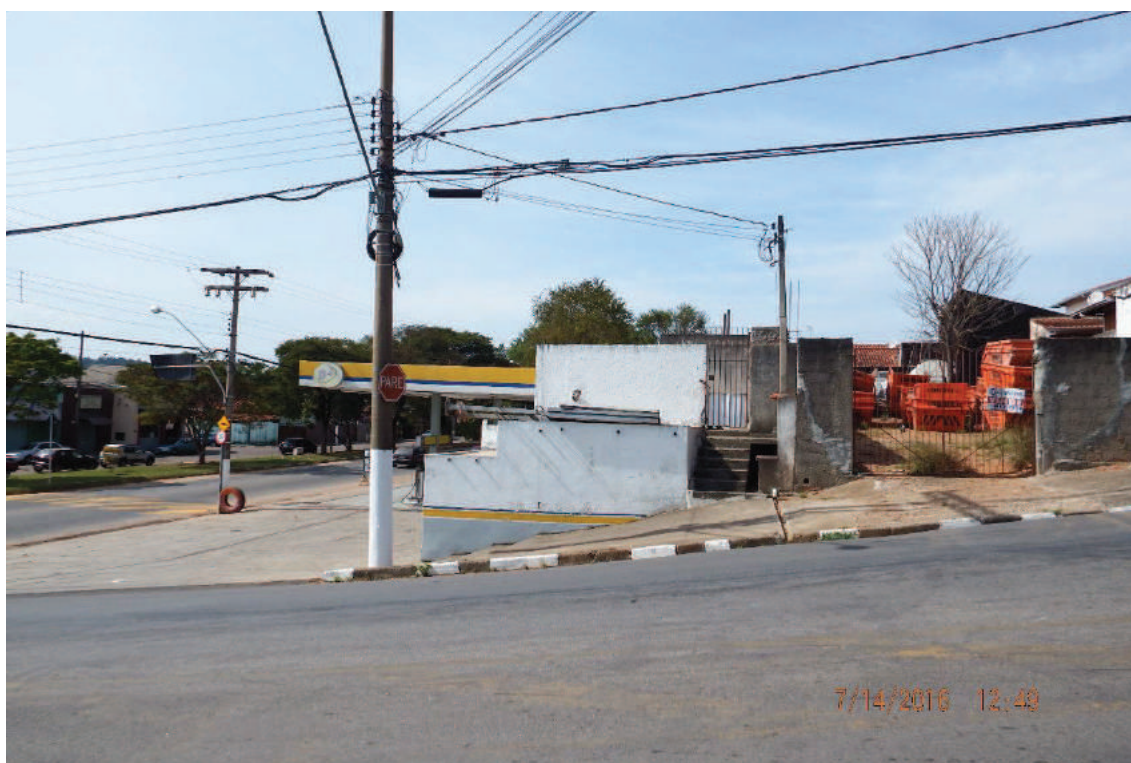
Foto 16 - Imóvel Residencial - Fachada Frontal
