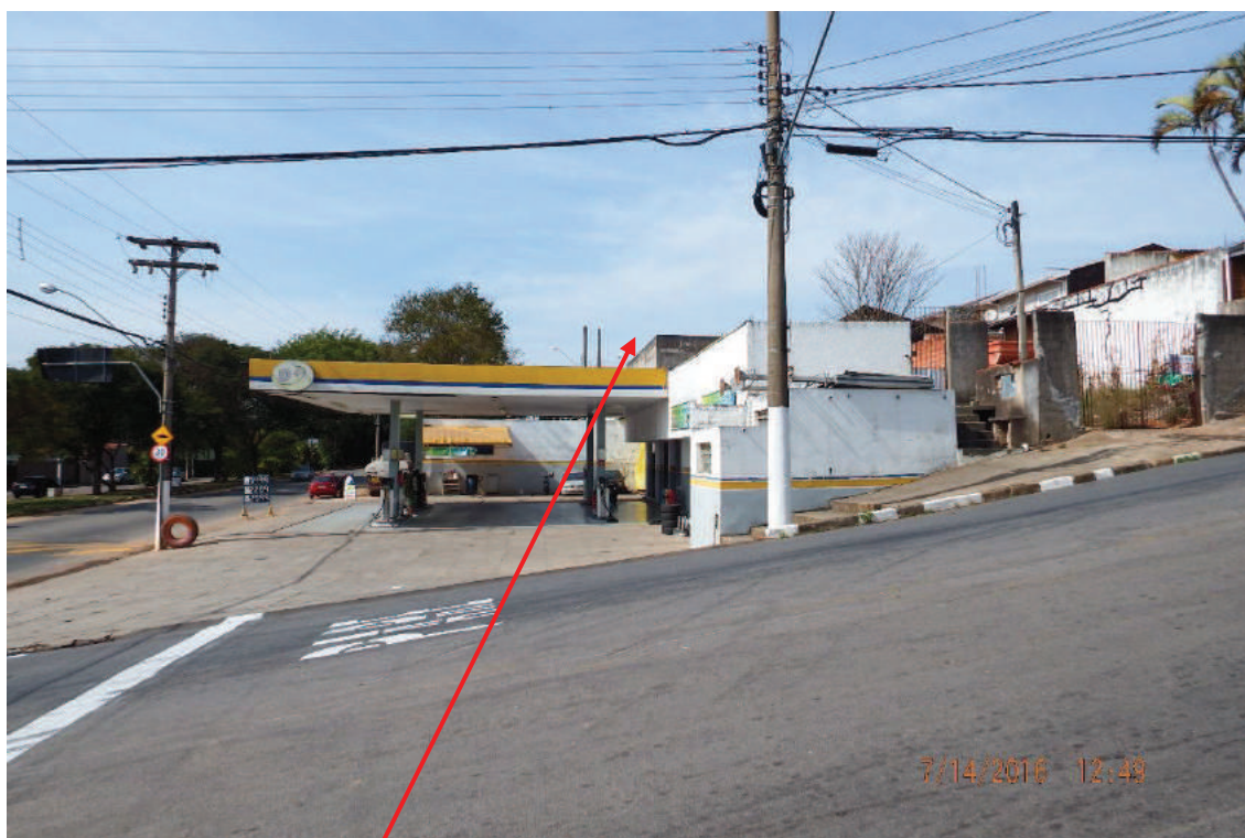
Foto 15 - Imóvel Residencial - em cima das lojas do posto (parede externa sem pintura).
