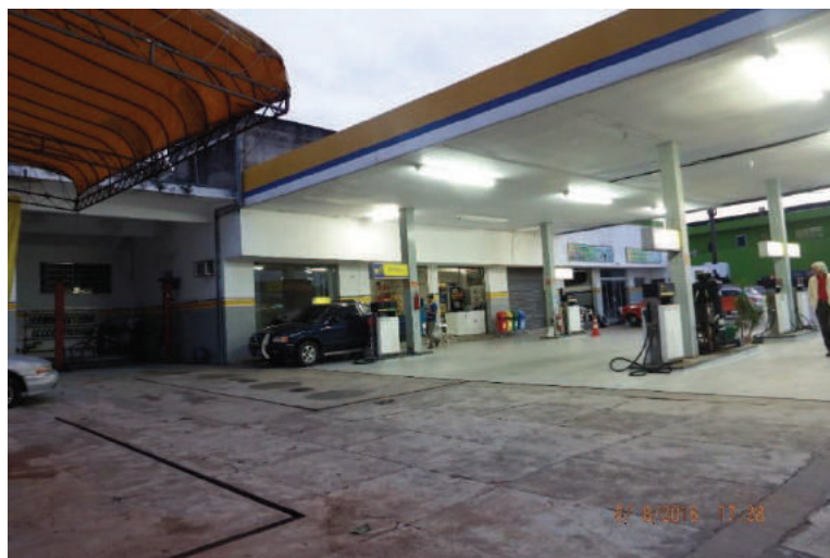
Foto 3 - Visão da pista - 5 bombas Área de Manutenção - Troca de óleo
