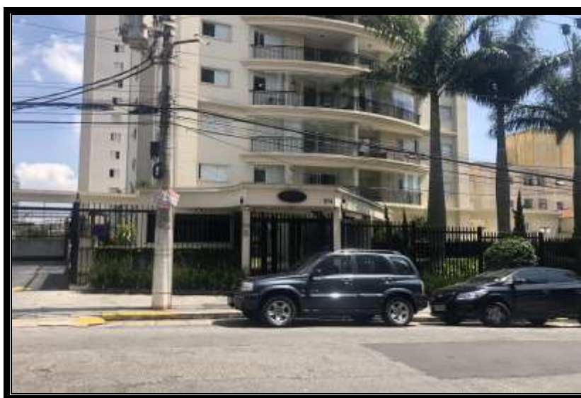
Vista Fachada do edifício no condomínio.
