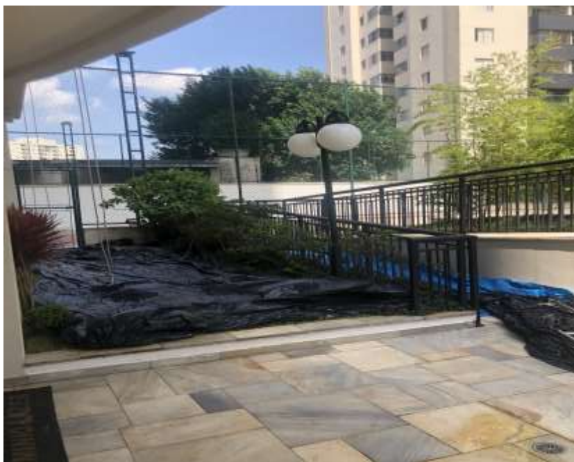
Foto – Rampa acesso piscinas.
