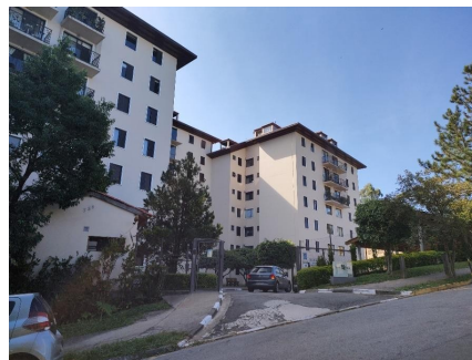
Representação Vista da Rua Descrição VIZINHO ESQUERDA Data Foto 23/05/2022
