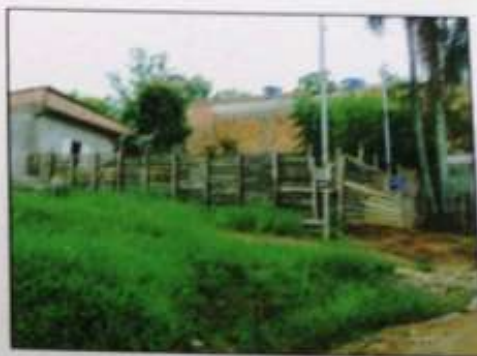
Foto 04: Frente do imóvel. Nota-se a subdivisão em lotes e benfeitorias.
