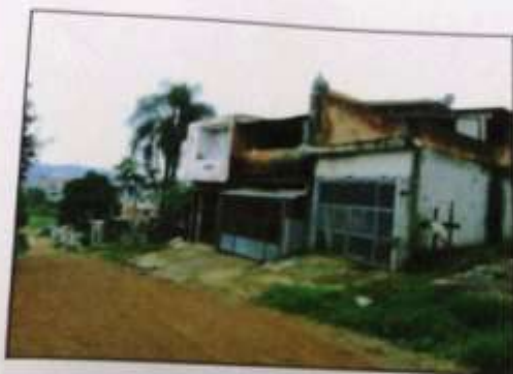
Foto 03: Frente do imóvel. Nota-se a subdivisão em lotes e benfeitorias.
