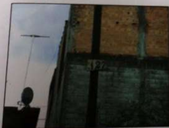
Foto 05: Detalhe da numeração das benfeitorias
