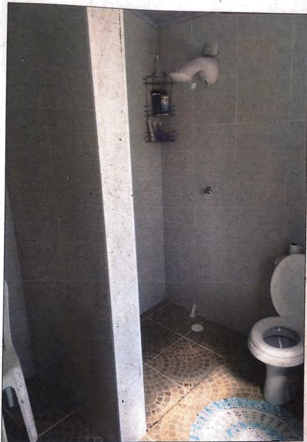
Vista do banheiro da suíte.
