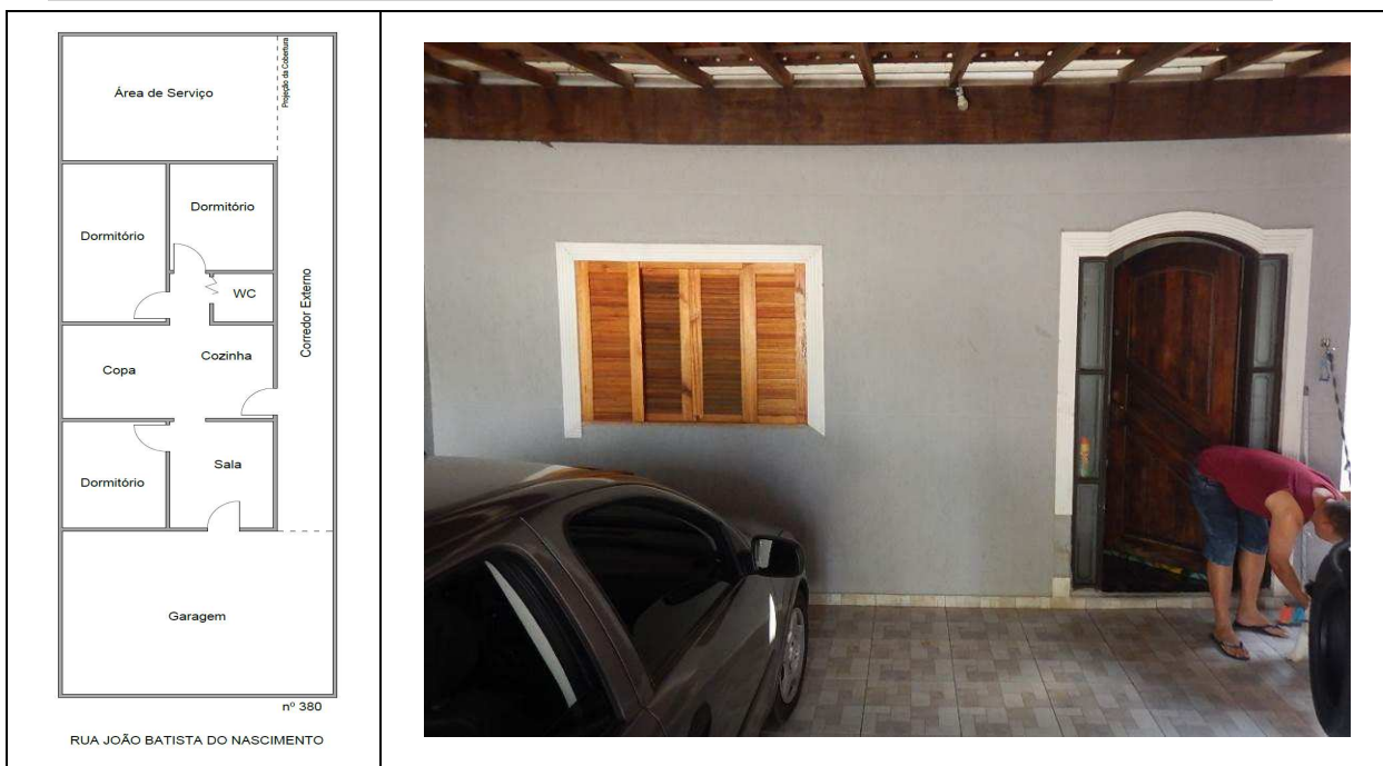
VISTA DA FACHADA DA CASA.
