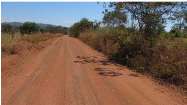
Estrada de acesso e divisa Oeste do imóvel.
