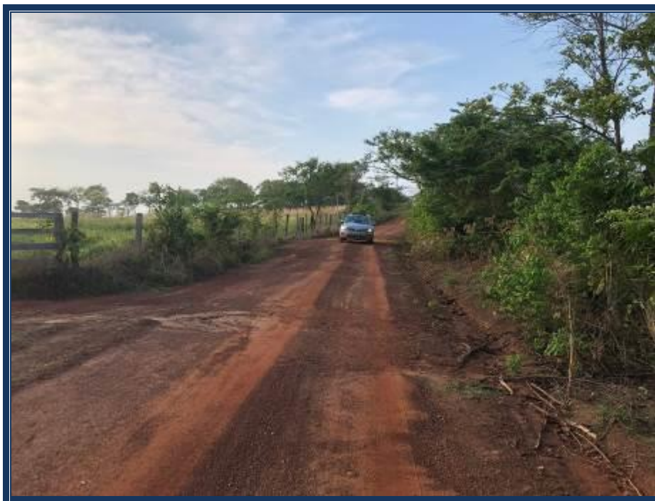
Vista da Estrada municipal que dá acesso à sede da gleba rural.
