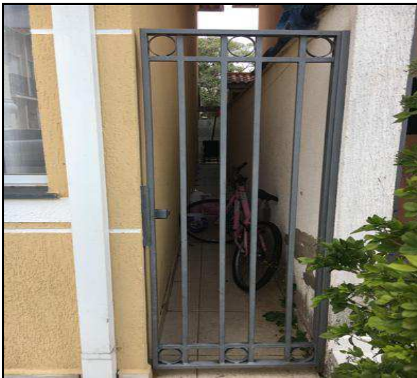
CORREDOR DO LADO DIREITO DO IMÓVEL
