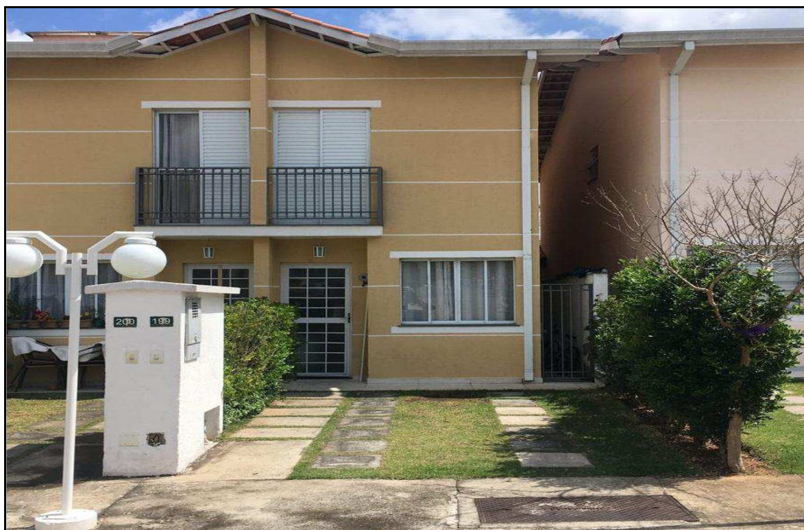
FRENTE DO IMÓVEL E DA ENTRADA SOCIAL/SERVIÇOS
