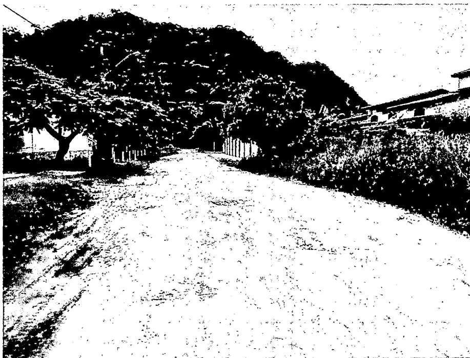
Figura 3 - VISTA DA RUA SABIA SENTIDO OPOSTO
