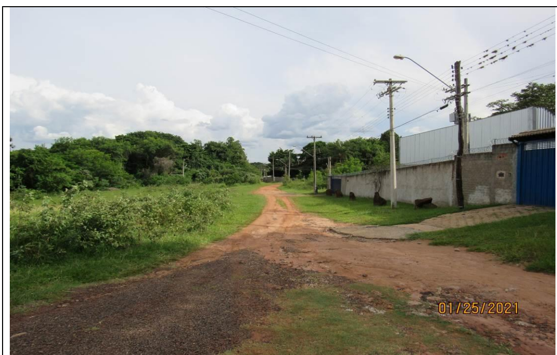
FOTO 03 – vista geral da via de acesso em terra.
