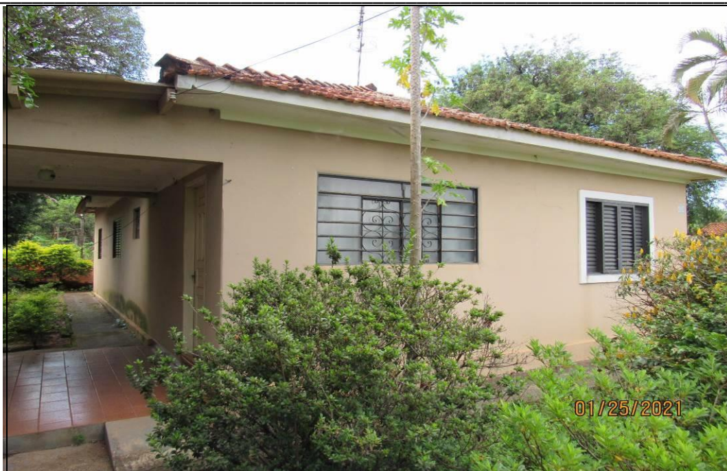
FOTO 12 – vista geral externa da edificação II.
