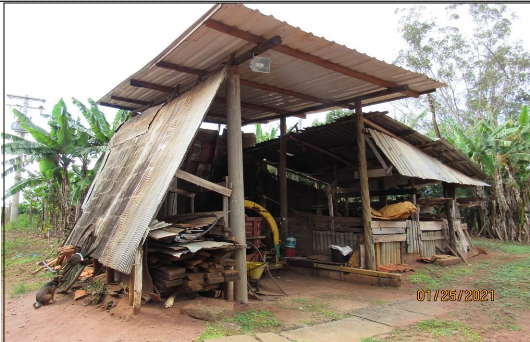
FOTO 18 – vista geral externa com demais edificações existentes na propriedade.
