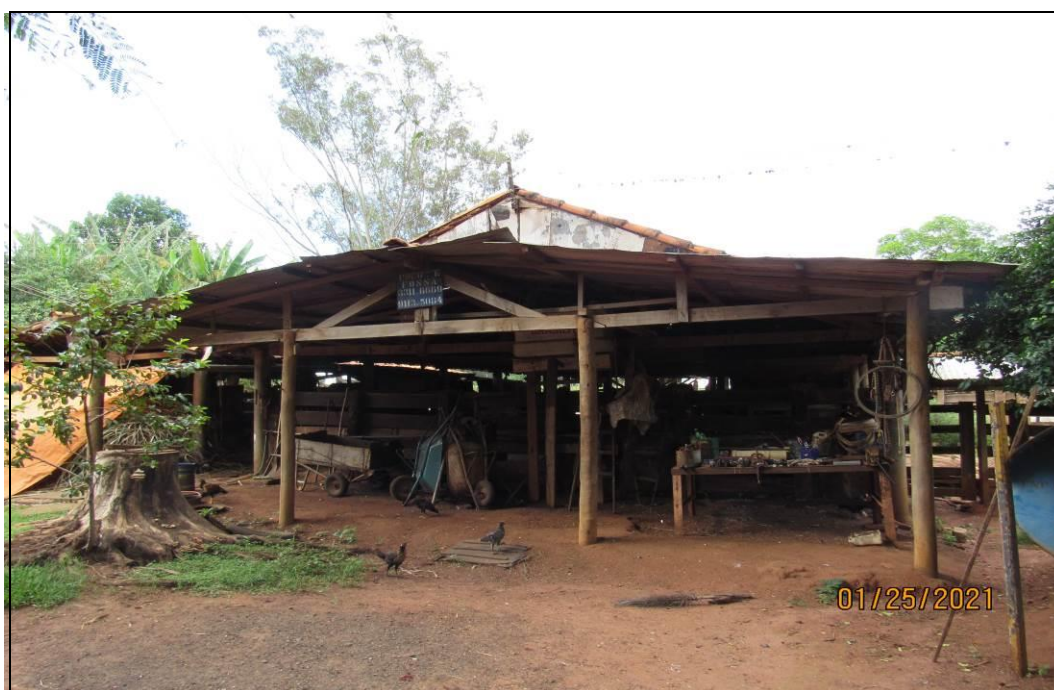
FOTO 15 – vista geral externa da oficina.
