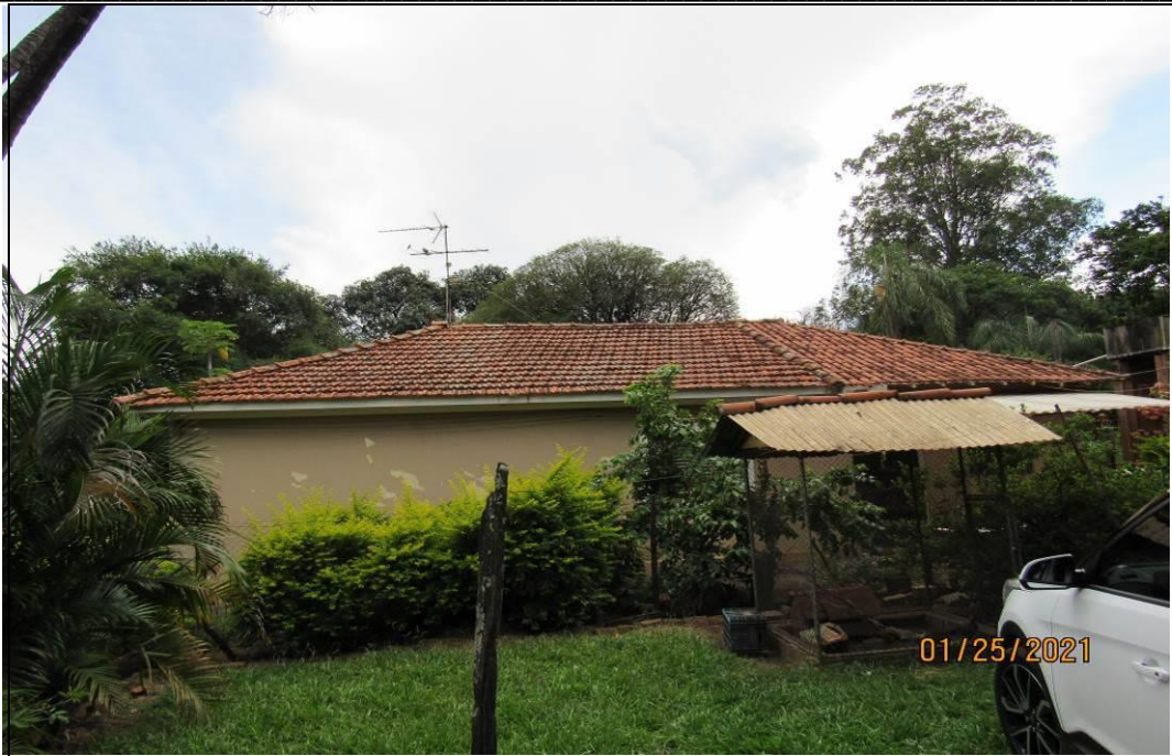
FOTO 10 – vista geral externa da edificação II.
