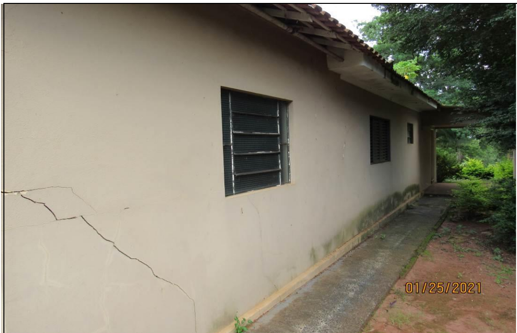
FOTO 11 – vista geral externa da edificação II.
