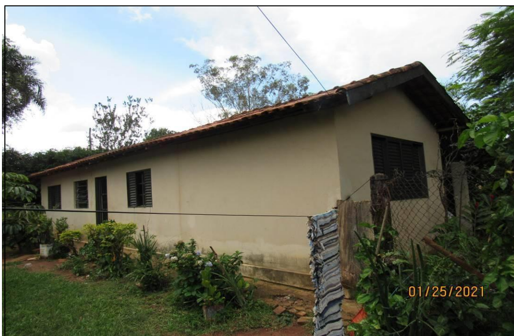
FOTO 09 – vista geral externa da edificação I.
