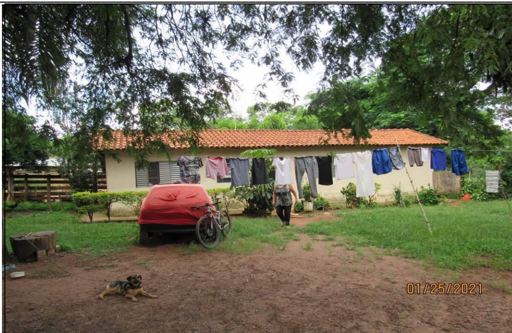
FOTO 08 – vista geral externa da edificação I.
