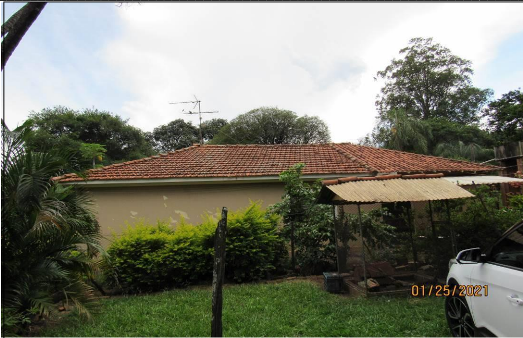
FOTO 10 – vista geral externa da edificação II.
