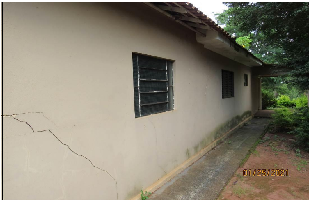
FOTO 11 – vista geral externa da edificação II.
