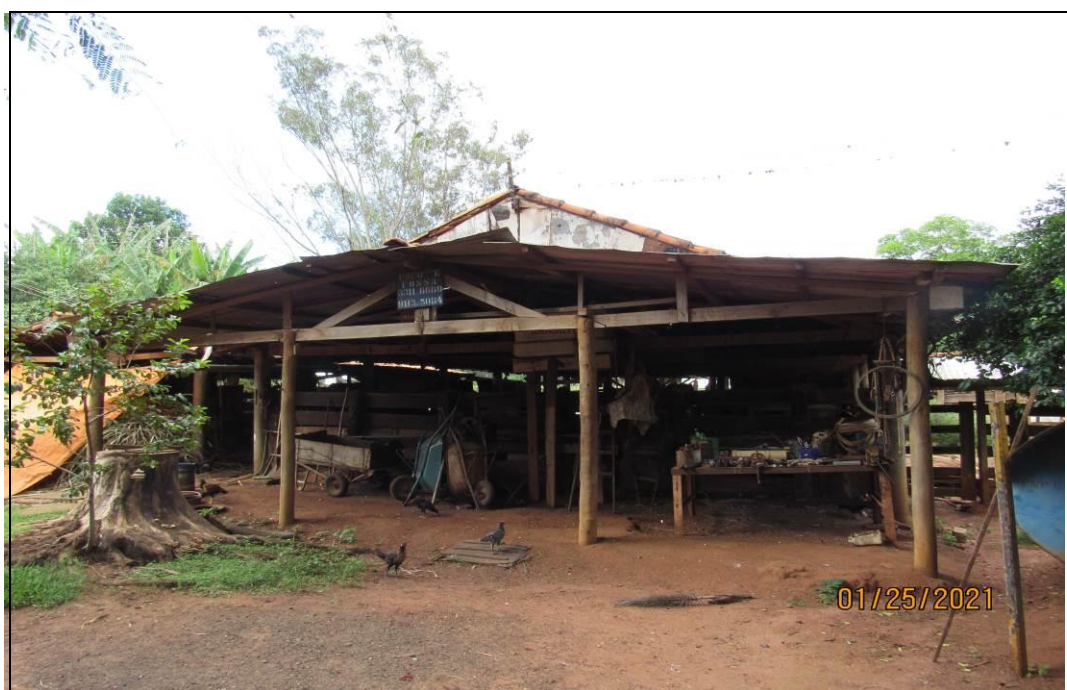
FOTO 15 – vista geral externa da oficina.
