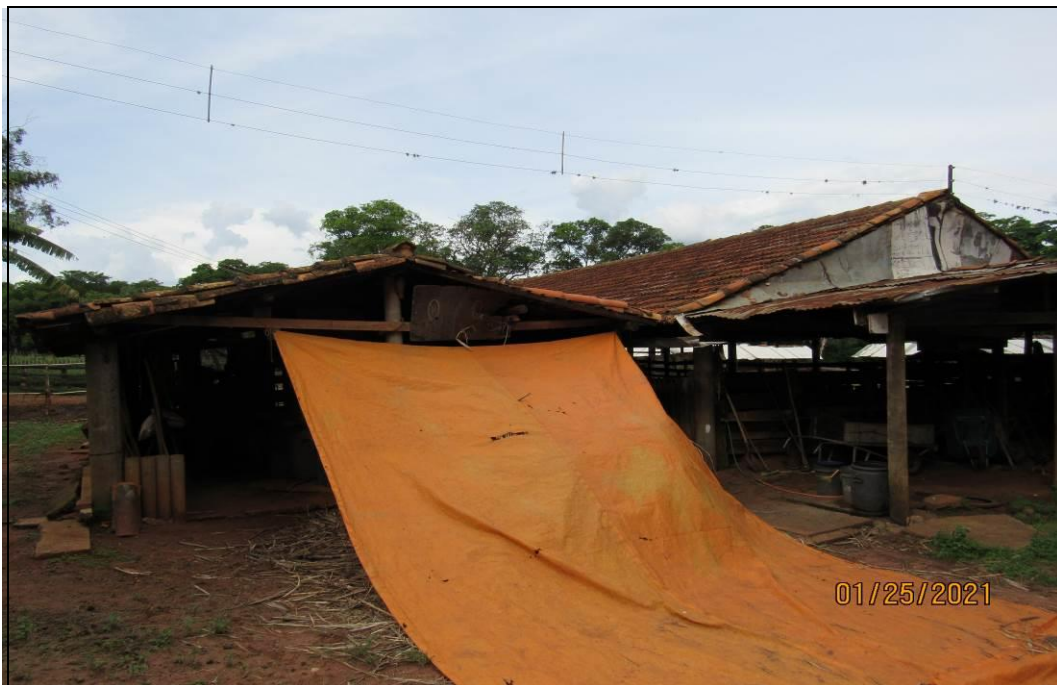
FOTO 17 – vista geral externa do celeiro.
