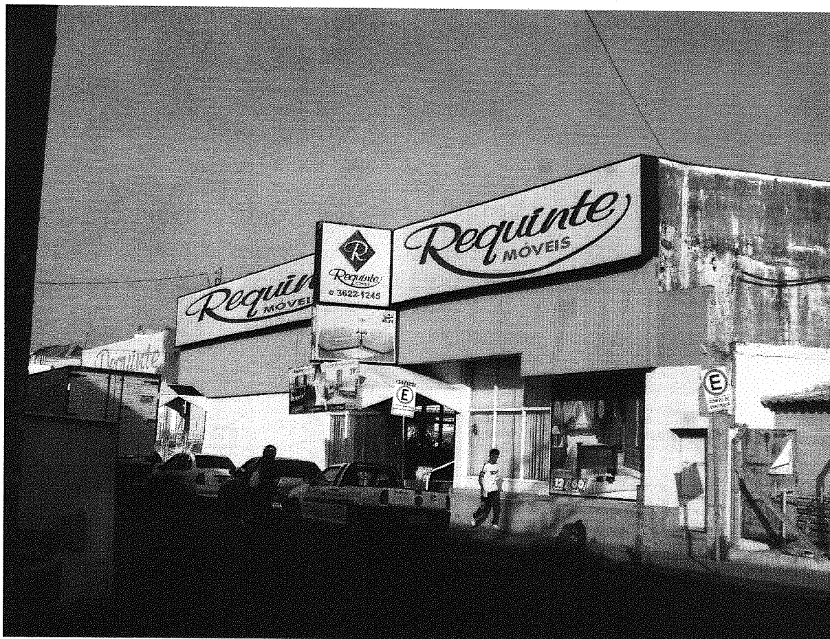
Foto nº 01: Fachada do imóvel.
