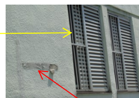
Superfícies descascadas, evidenciam a necessidade de repintura do edifício.
