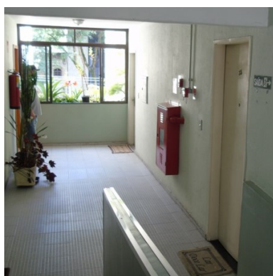
Corredor de acesso ao apartamento nº 33 B
