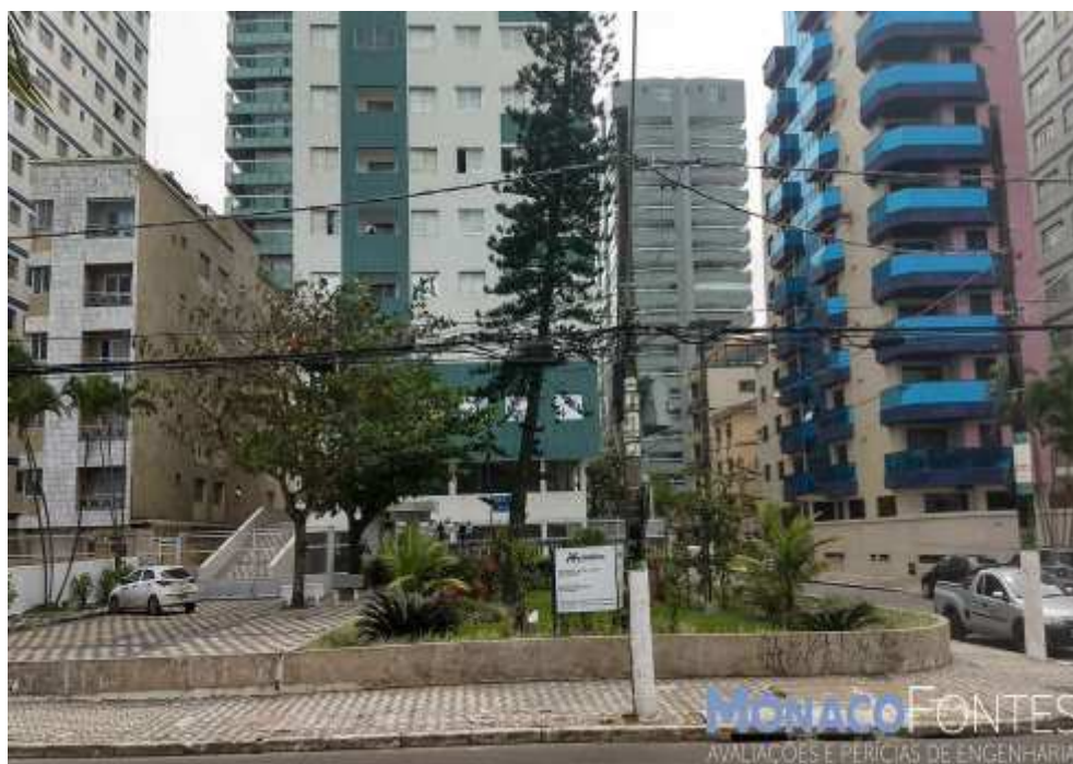
Acima, temos uma tomada da testada do Condomínio Edifício Fumio Miyazi.
