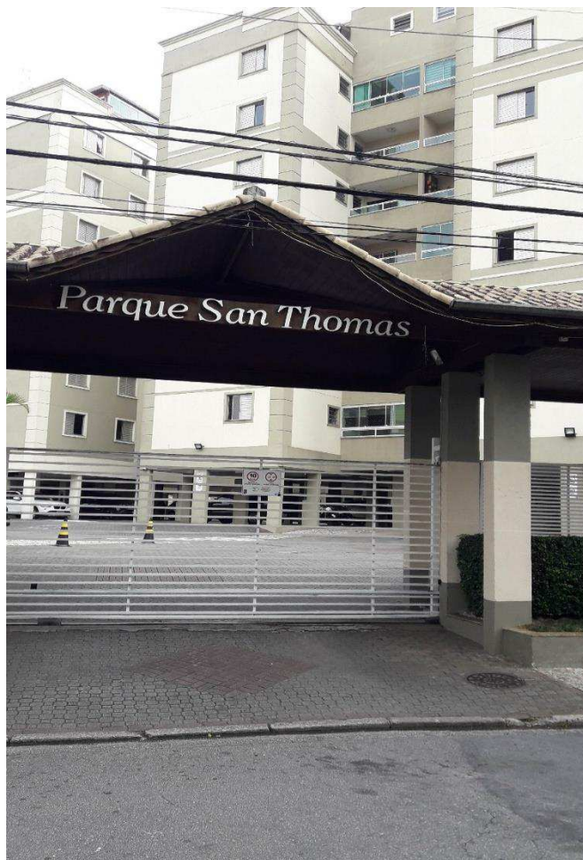
Vista de Identificação do Prédio
