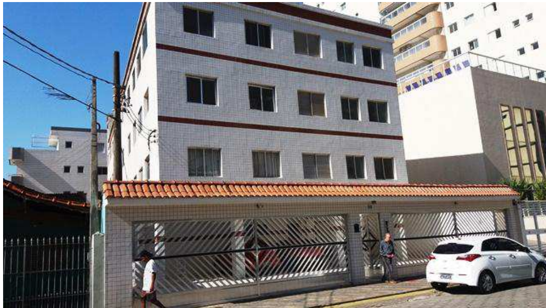
Foto 01 - Frente do edifício para Rua Vasco da Gama.
