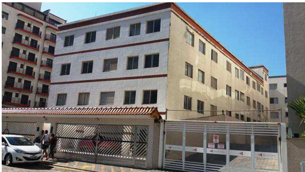
Foto 02 - Vista do lado direito do edifício.
