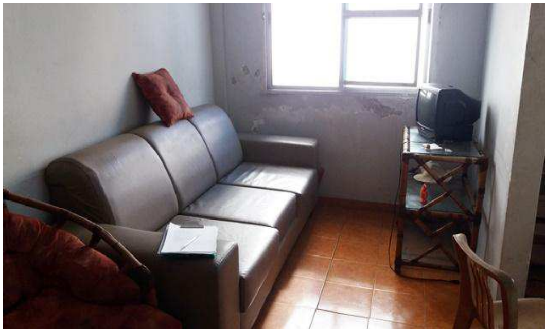
Foto 08 - Sala com piso cerâmico com pequenos problemas na pintura.
