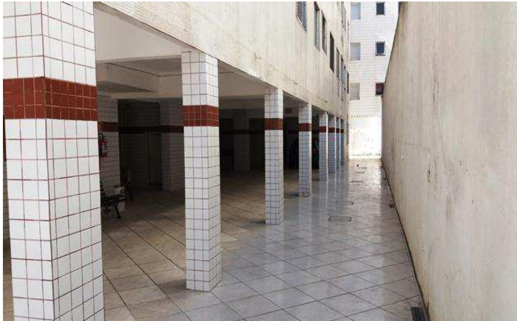
Foto 03 - Lateral do edifício e garagem de autos.
