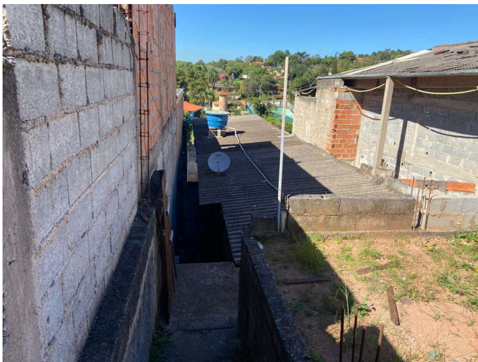
ESCADA PARA ACESSO AO IMÓVEL
