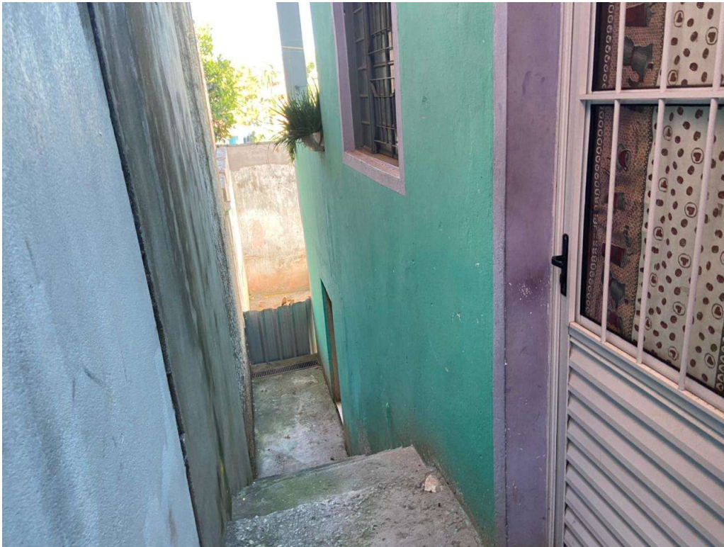
VISTA ESCADA ACESSO AO PORÃO E AO QUINTAL
