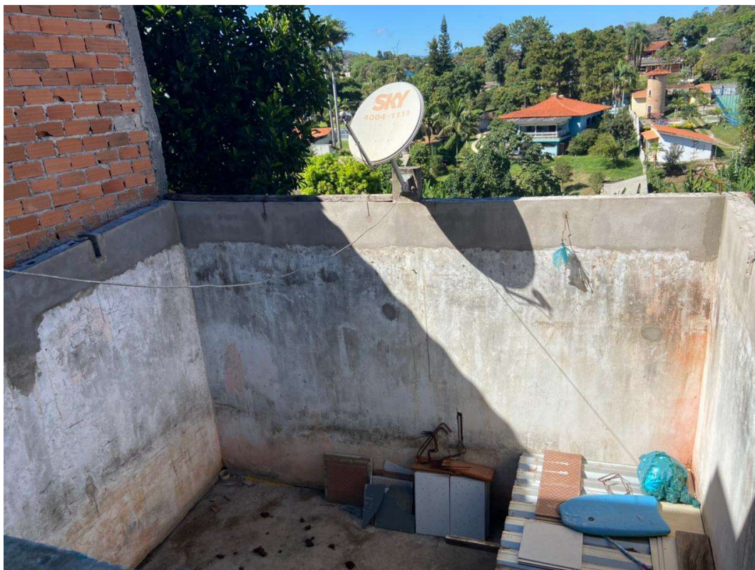
QUINTAL (SEM COBERTURA, MARCAS DA ANTIGA ESTRUTURA DO TELHADO REMOVIDO)
