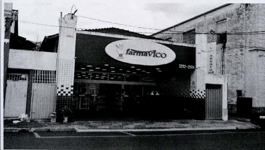
FOTO 50 – Foto da Fachada
