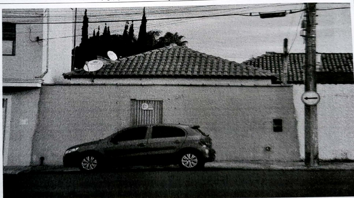
FOTO 17 – Foto da Fachada
