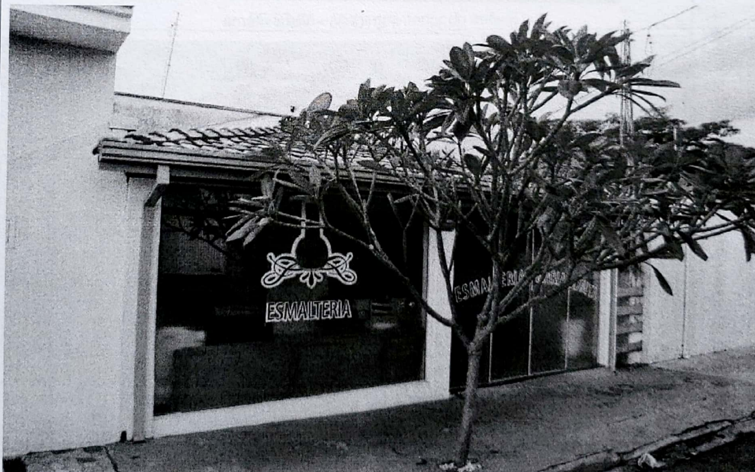
FOTO 25 – Foto da Fachada
