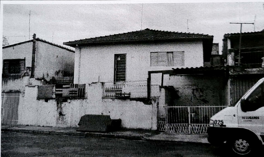
FOTO 15 – Foto da Fachada
