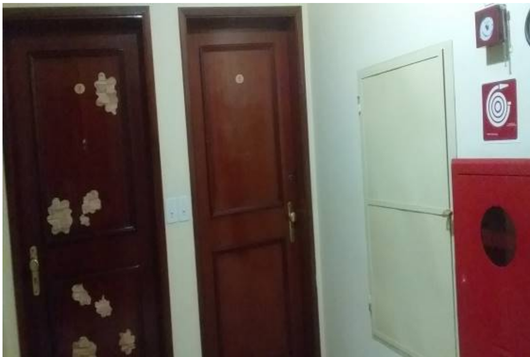
FOTO Nº 10 – Vista do hall do 1º pavimento, onde se localiza o apartamento nº 11.
