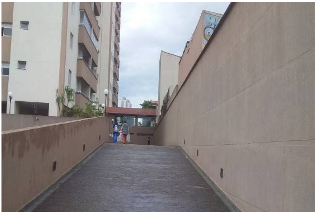
FOTO Nº 04 – Vista da rampa de acesso para o bloco 02.
