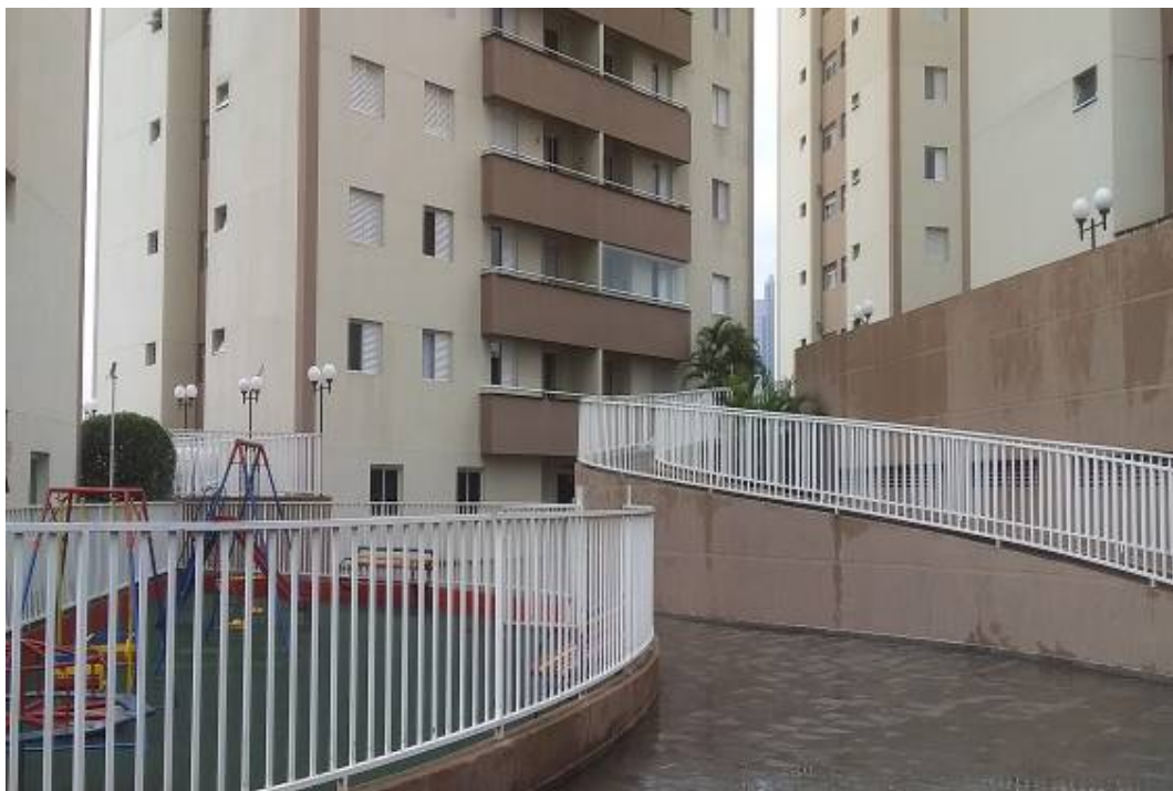
FOTO Nº 05 – Vista da rampa de acesso ao bloco 02, tomada de outra posição.
