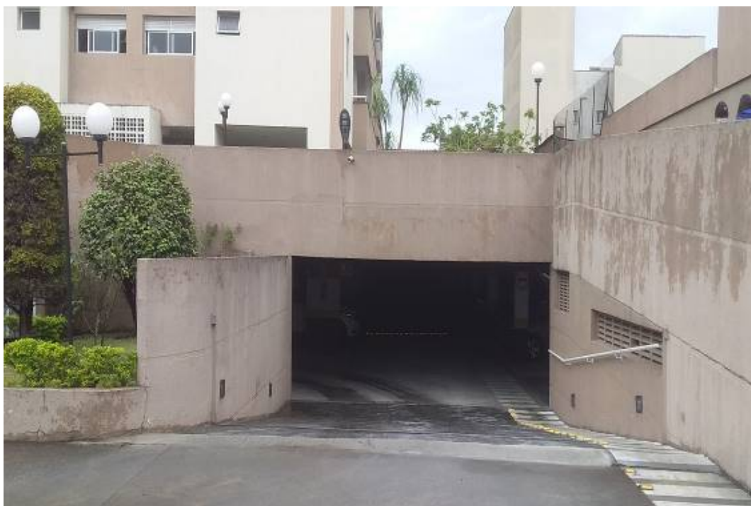
FOTO Nº 03 – Vista da entrada de acesso à área de estacionamento.
