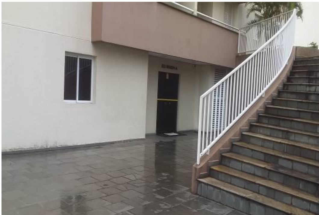
FOTO Nº 06 - Vista do bloco 02, do Edifício Begônia.
