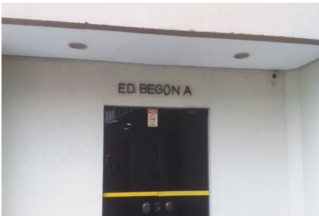
FOTO Nº 07 – Vista do acesso ao bloco 02.
