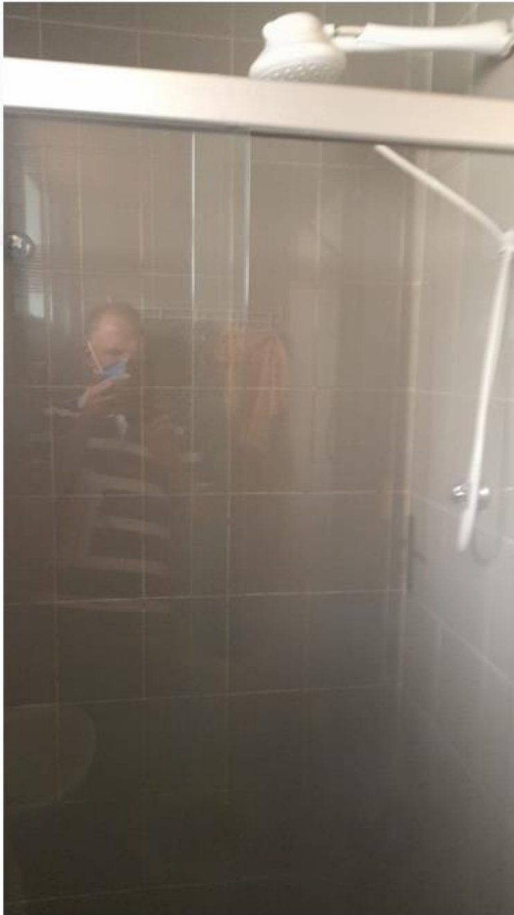
Figura 30 banheiro da área de lazer
