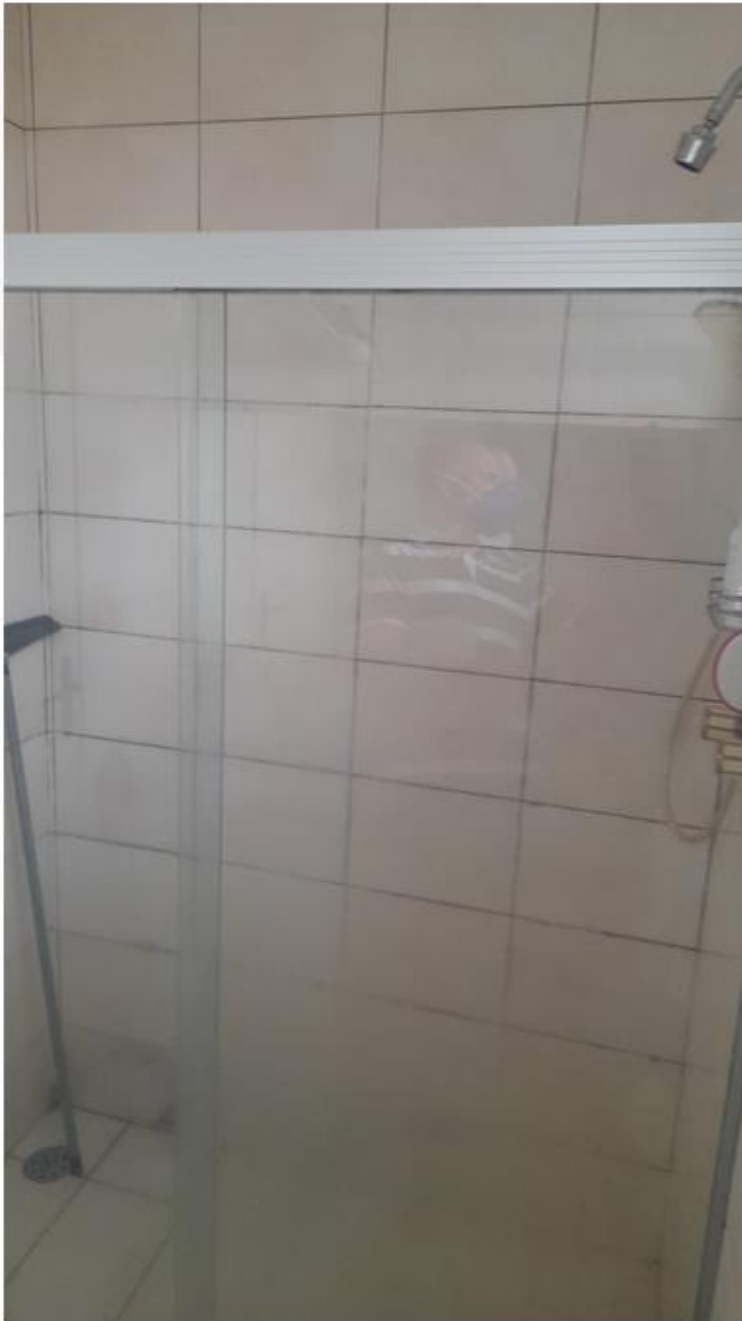
Figura 40 chuveiro do banheiro
