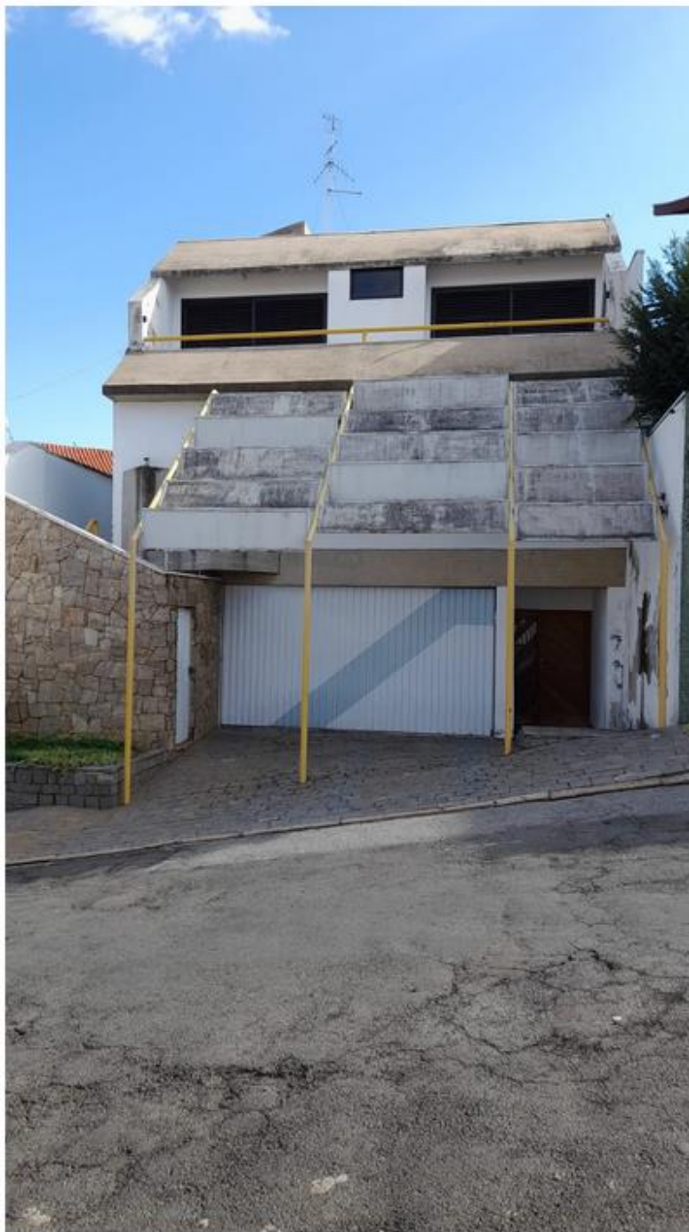
Figura 1 frente do imóvel
