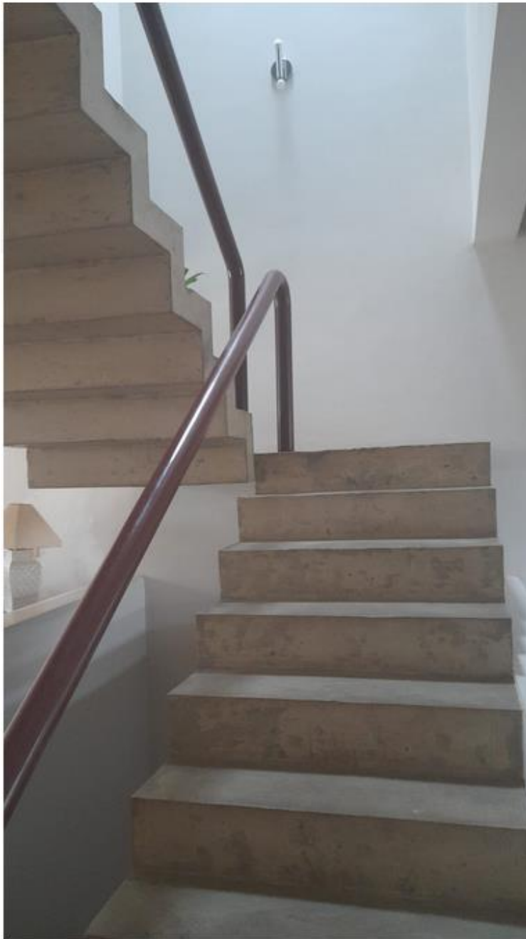
Figura 33 escada para o pavimento superior
