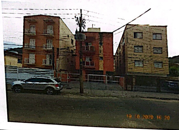
Vista Frontal do Prédio
