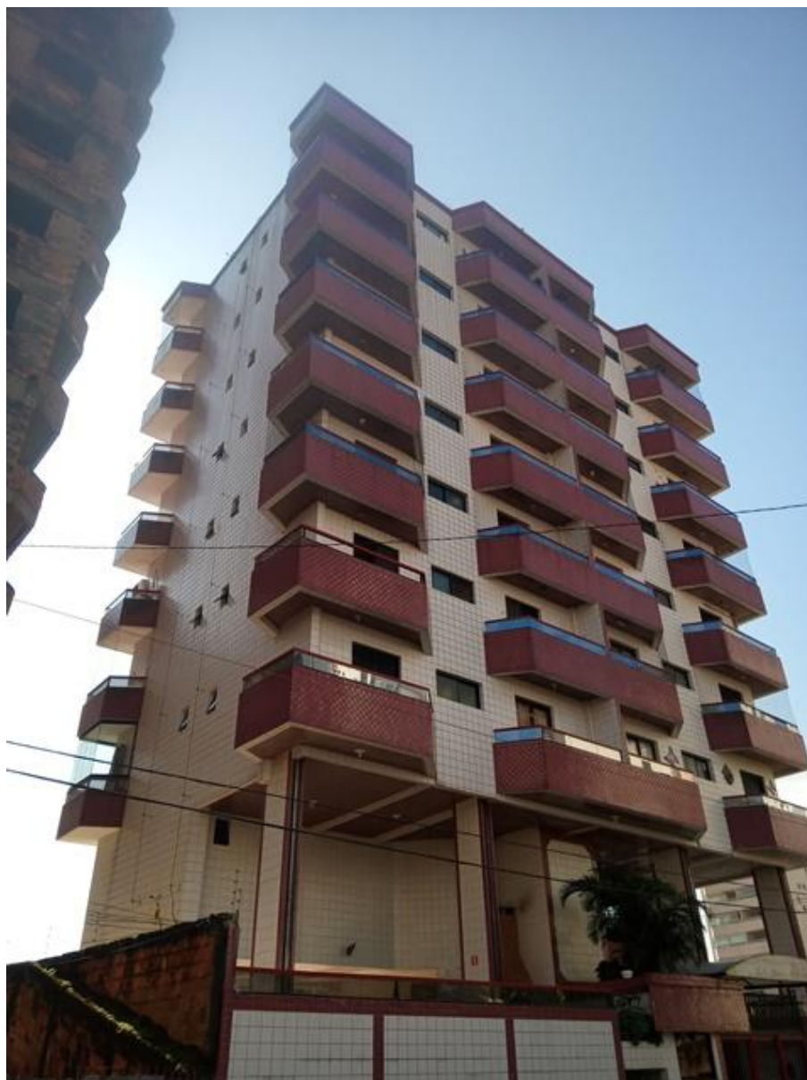
Foto 02 - Vista lateral direita
