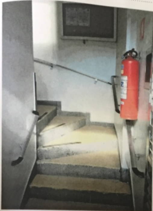
Escada de acesso aos pavimentos superiores
