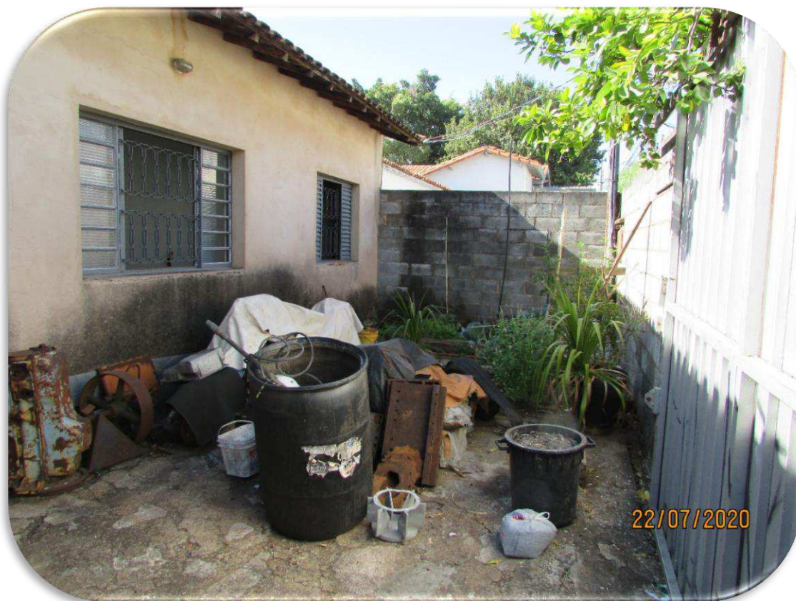
Figura 7 – Vista recuo frontal.
