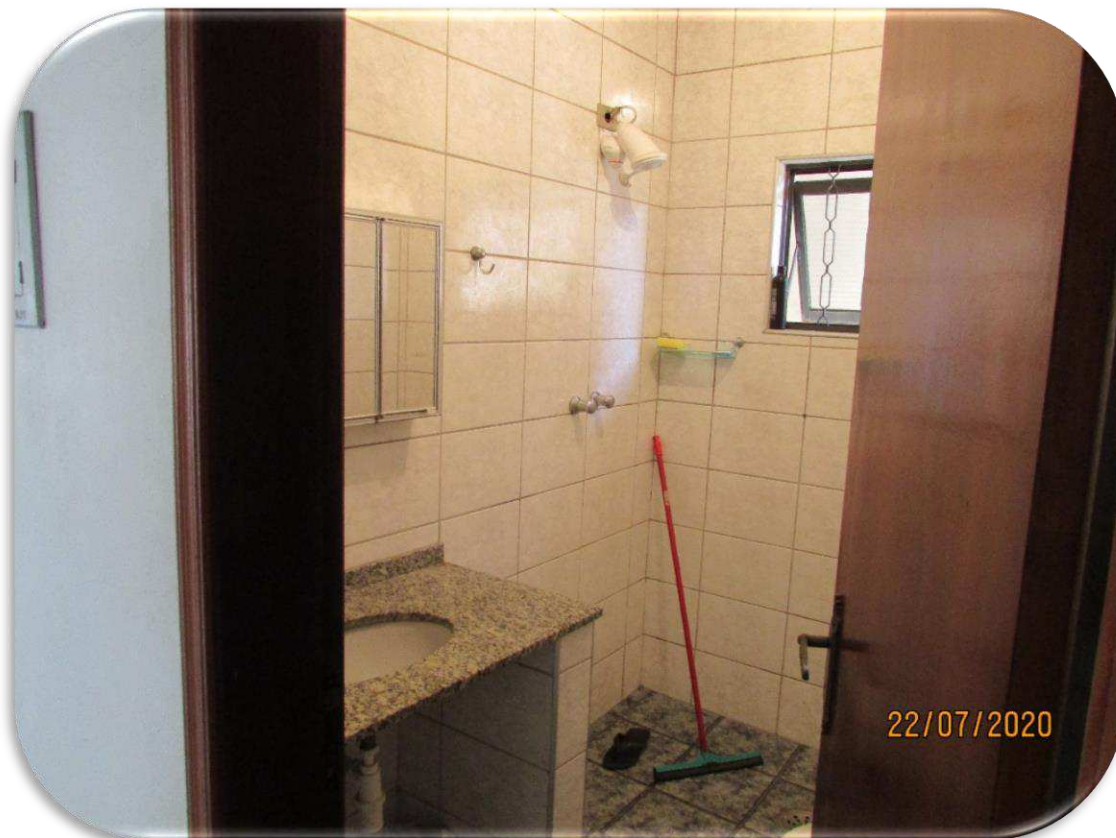
Figura 11 – Vista do Banheiro
