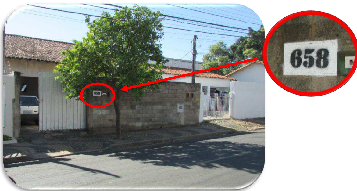
Figura 5 – Vista frontal do imóvel
