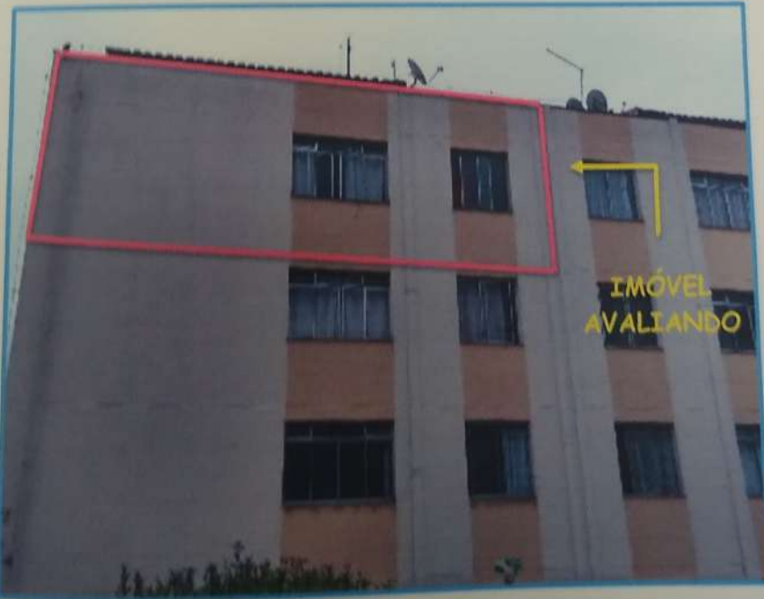
FACHADA DO BLOCO 3 COM DESTAQUE PARA UNIDADE AVALIANDA.
