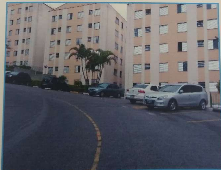
VIA DE CIRCULAÇÃO E ACESSO AOS BLOCOS.
