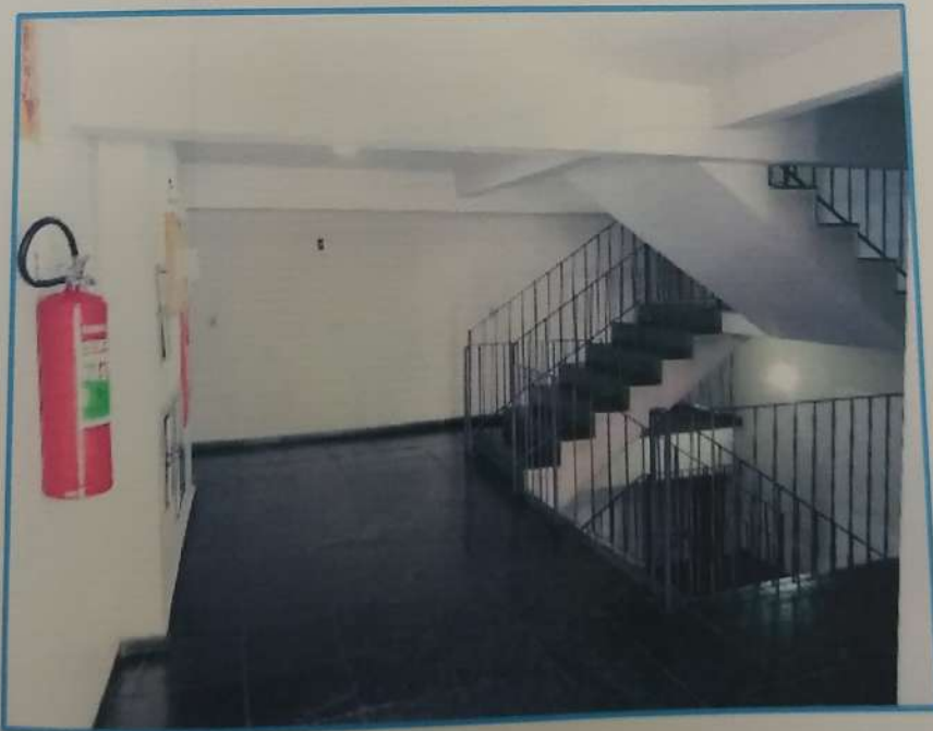
PORTA DE ACESSO E HALL DO BLOCO 3.
