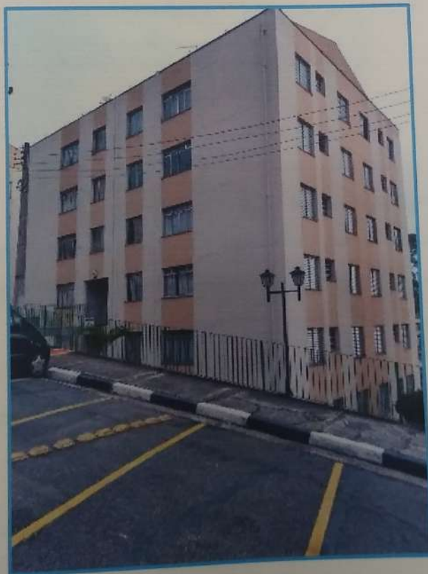
FACHADA DO BLOCO 3 DO CONDOMÍNIO CONJUNTO RESIDENCIAL GREEN LAND.
