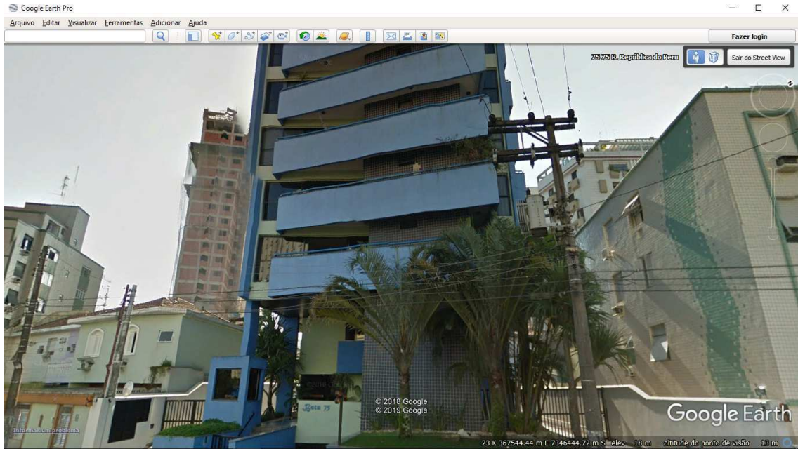
FOTO 01 - Vista fachada da frente Condomínio Edifício Beta
