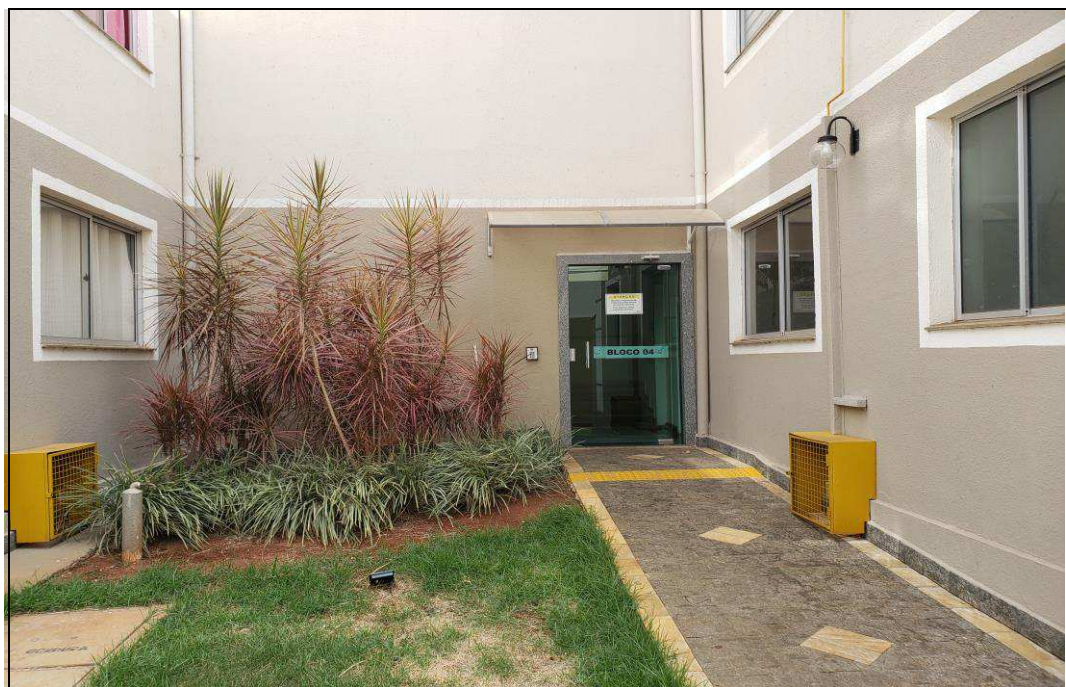
FOTO 02 – Vista frontal do bloco 04.
