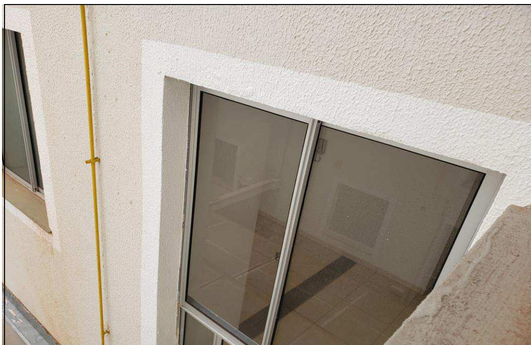
FOTO 04 – Vista geral externa do apartamento, onde também observamos o interior do mesmo.
