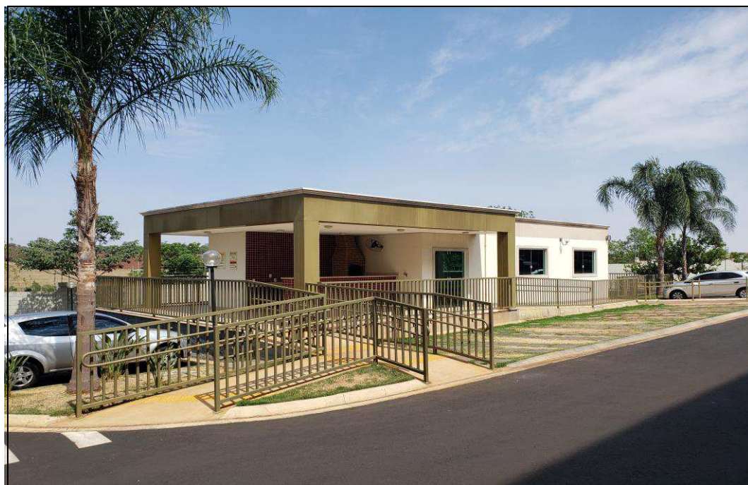
FOTO 06 – Vista do salão de festas do condomínio.
