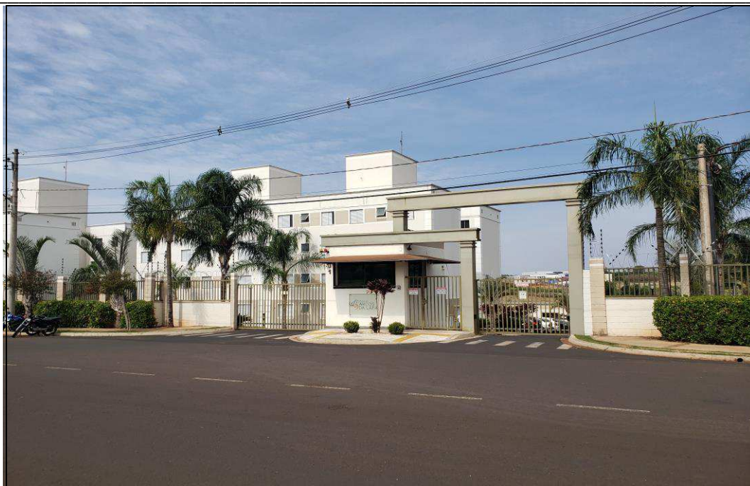
FOTO 01 – Vista frontal do condomínio Arcos da Lapa.
