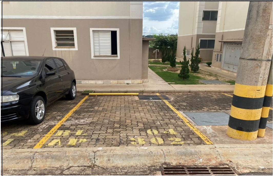
FOTO 07 – Vista geral da garagem no condomínio.
