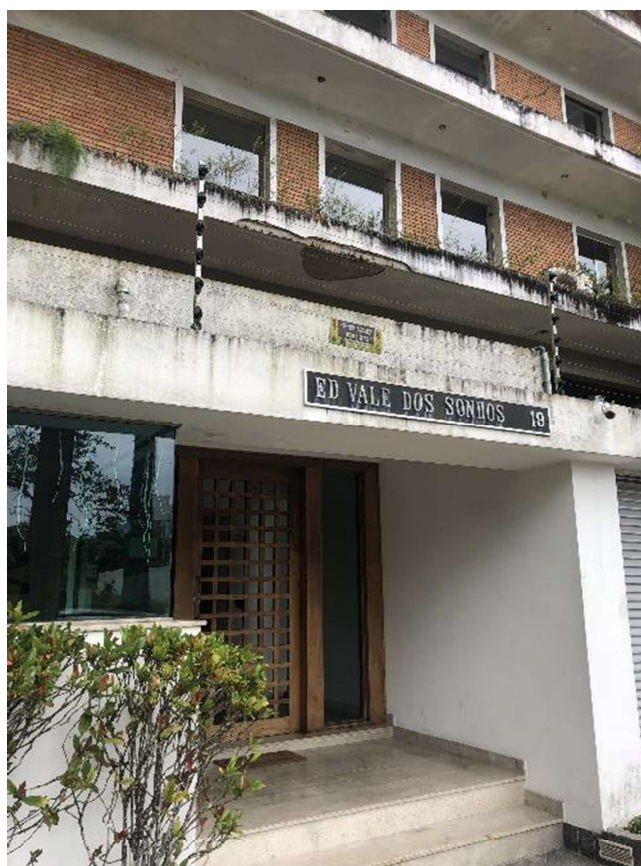
Figura 9 - Vista parcial frontal do Edifício avaliado, acesso pedestres.
