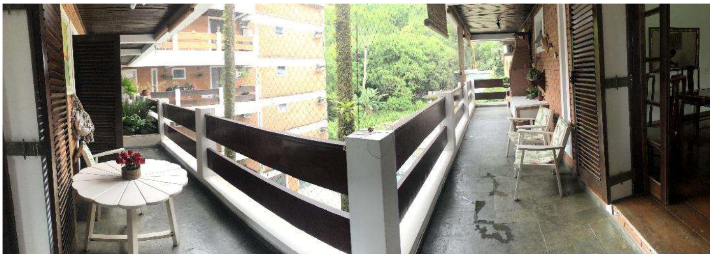
Figura 22 – Varanda em “L” com churrasqueira e vista para o pátio interno do Edifício.
