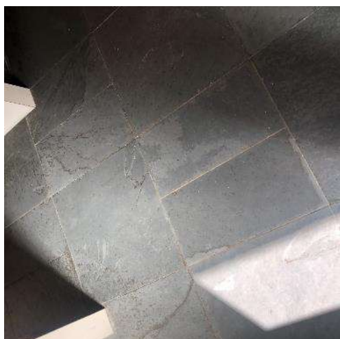
Figura 31 - Detalhe Piso serviços.
