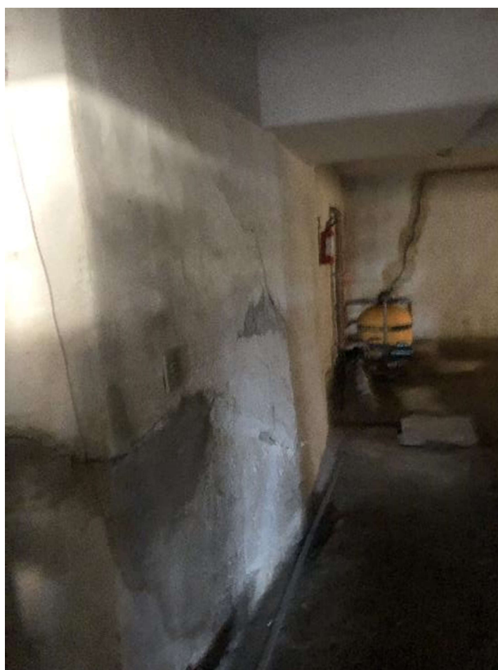
Figura 60 – Área fechada atrás das vagas de garagem “depósito”. (foto acrescentada).
