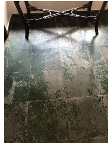
Figuras 20, 21 e 22 – Hall Social (Piso em defasada estado de conservação ou falta de manutenção adequada).
