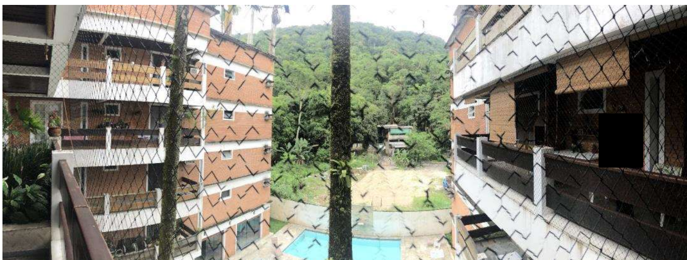
Figura 23 – Vista da Varanda.
