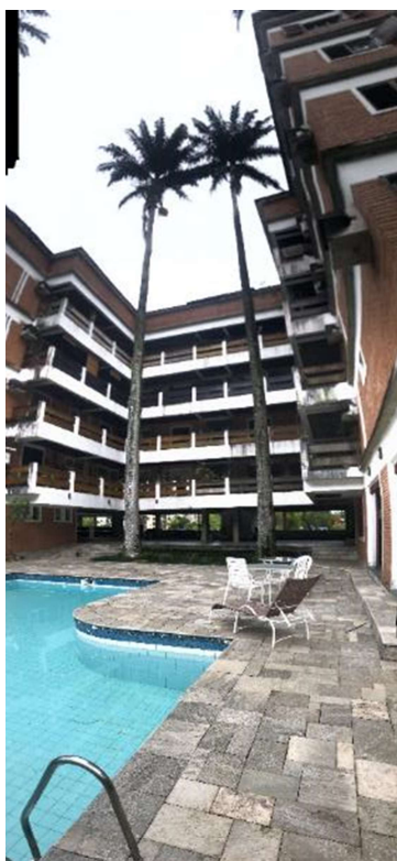
Figura 17 – Vista “Pátio Interno” do Edifício.
