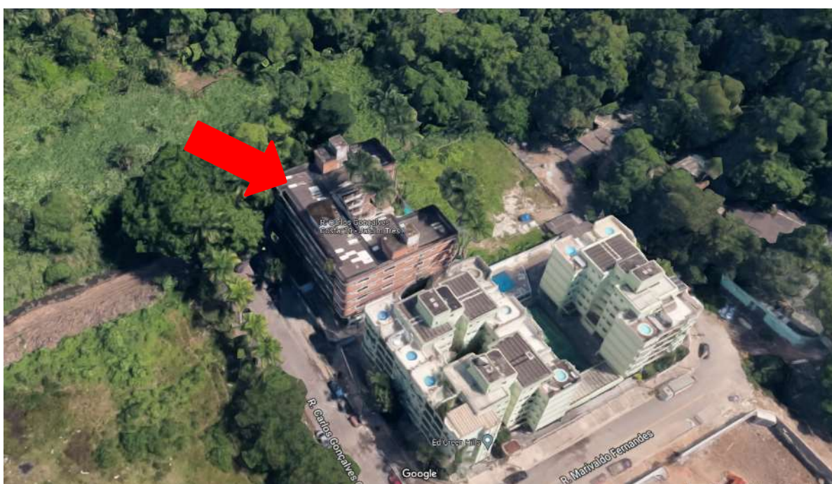
Figura 3 – Imagem Satélite revelando a Volumetria do Edifício Avaliado Fonte: Google Maps.
