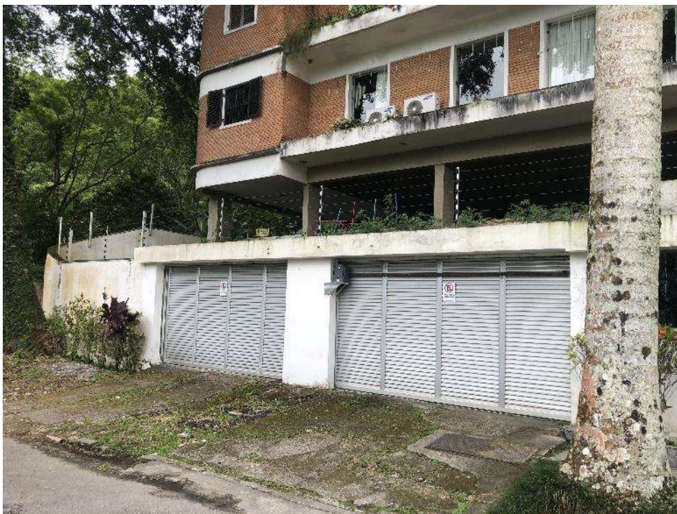
Figura 8 - Vista parcial frontal do Edifício avaliado, acesso autos.
