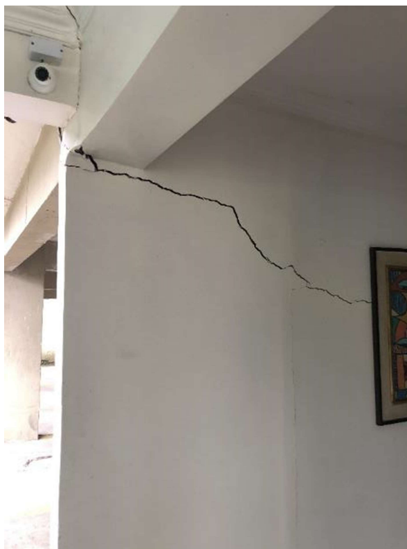
Figura 48 – Ao lado da Garagem no térreo, acesso ao hall de entrada Trica no superior da parede encontro com a viga.
