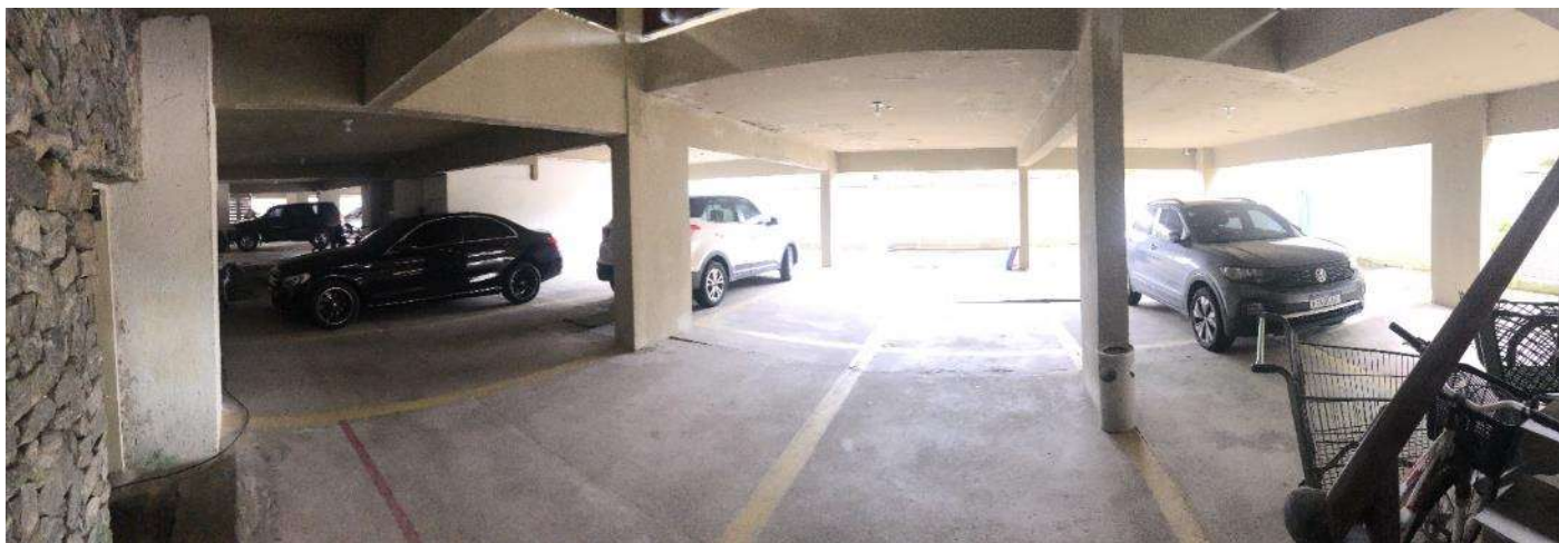
Figura 19 – Área de Garagens térreo.
