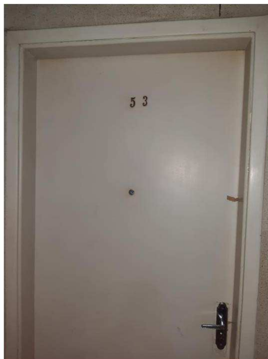
Entrada de serviço do apartamento
