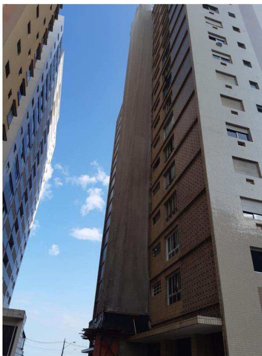
Vista lateral fachada (reforma)
