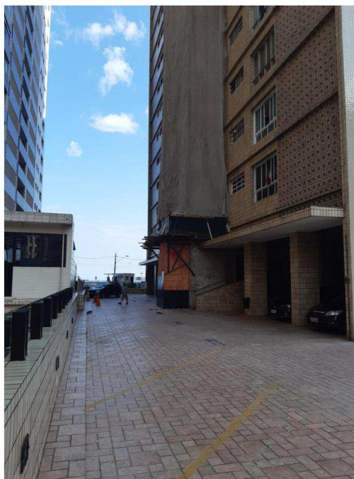
Acesso garagens térreo
