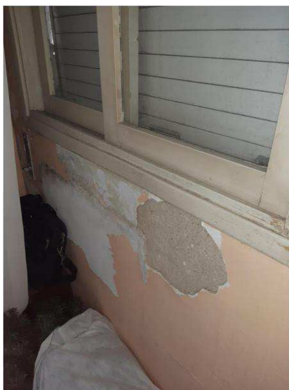
Quarto 1 – vista reparos parede
