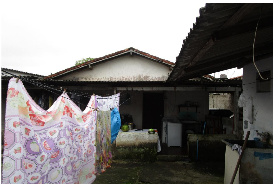
Foto nº 04: Vista dos fundos da edificação principal vendo-se a existência de área coberta com telhas de fibrocimento.
