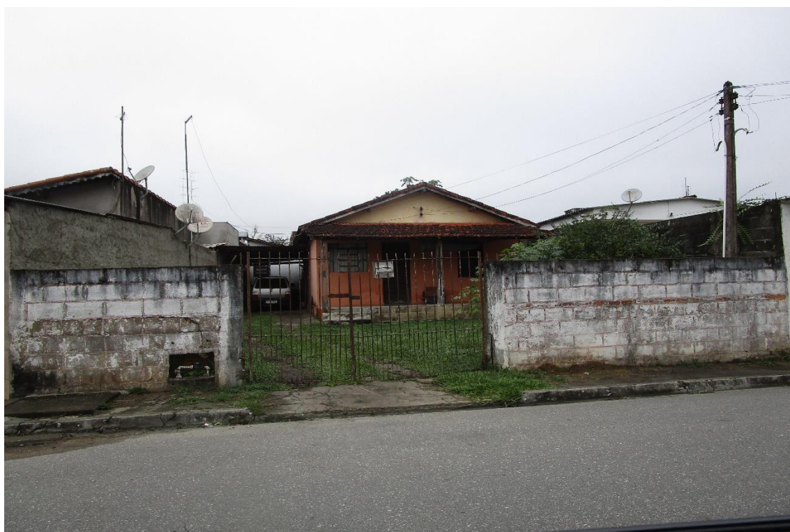
Foto nº 01: Vista do imóvel objeto da presente avaliação situado à Rua das Tulipas, nº 51, neste município de Registro.
