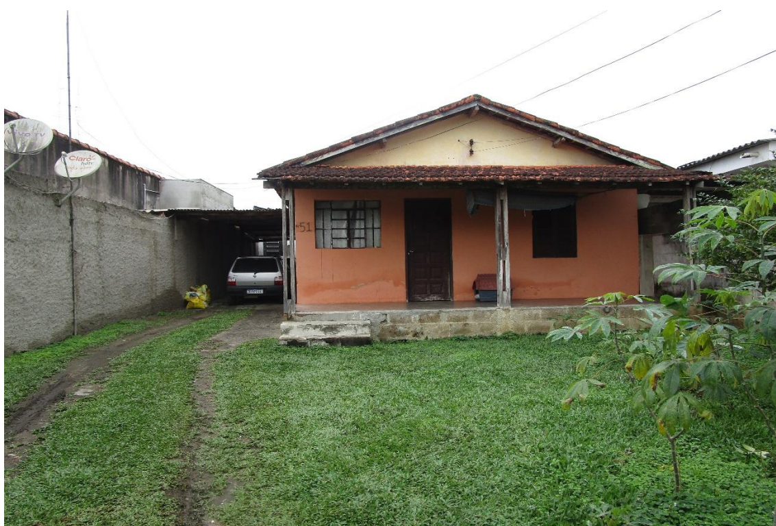
Foto nº 02: Vista interna do imóvel vendo-se a edificação principal erigida em alvenaria coberta com telhas de barro.
