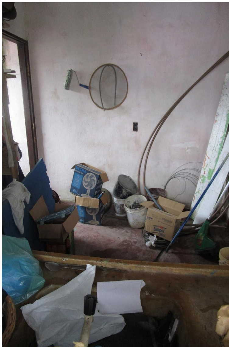
Foto nº 09: Vista interna da edícula. Suas principais características construtivas são: piso cimentado vermelhão, paredes revestidas em massa pintadas em látex sem forro coberta com telhas de fibrocimento.
