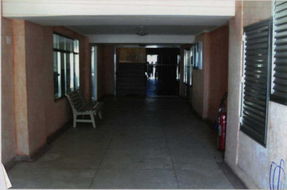
foto nº 7 - hall de entrada do Condomínio com piso de granilite, ao fundo escada de acesso aos pavimentos superiores.
