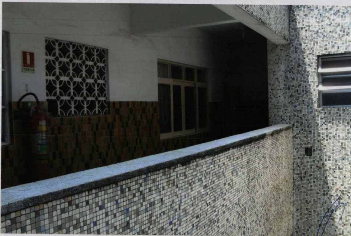
foto nº 13 - detalhe da porta e da janela do apartamento nº 313-avaliando, localizado no 3º andar do Edifício Glória
