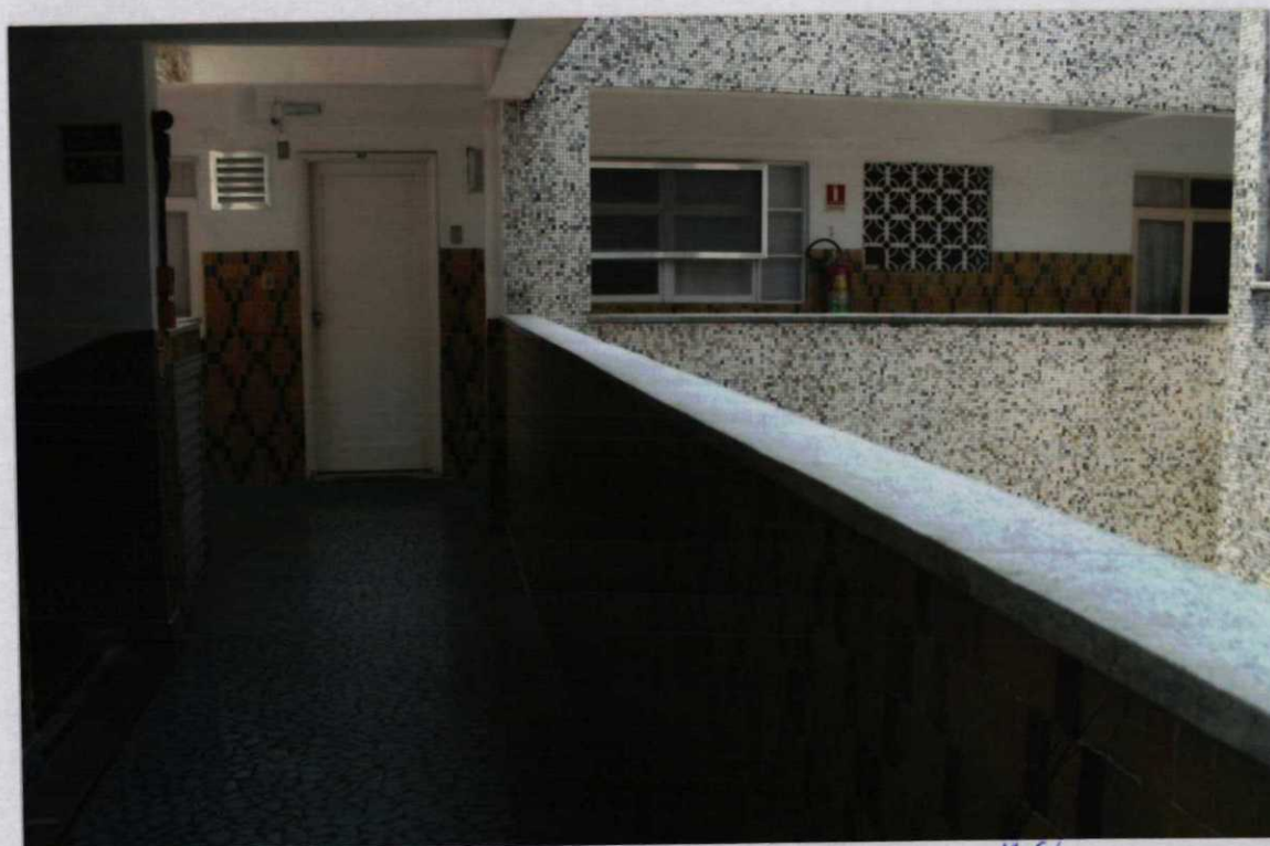
foto nº 12 - Corredor no 3º andar que dá acesso ao apartamento nº 313- avaliando, com pavimentação de caco cerâmico.
