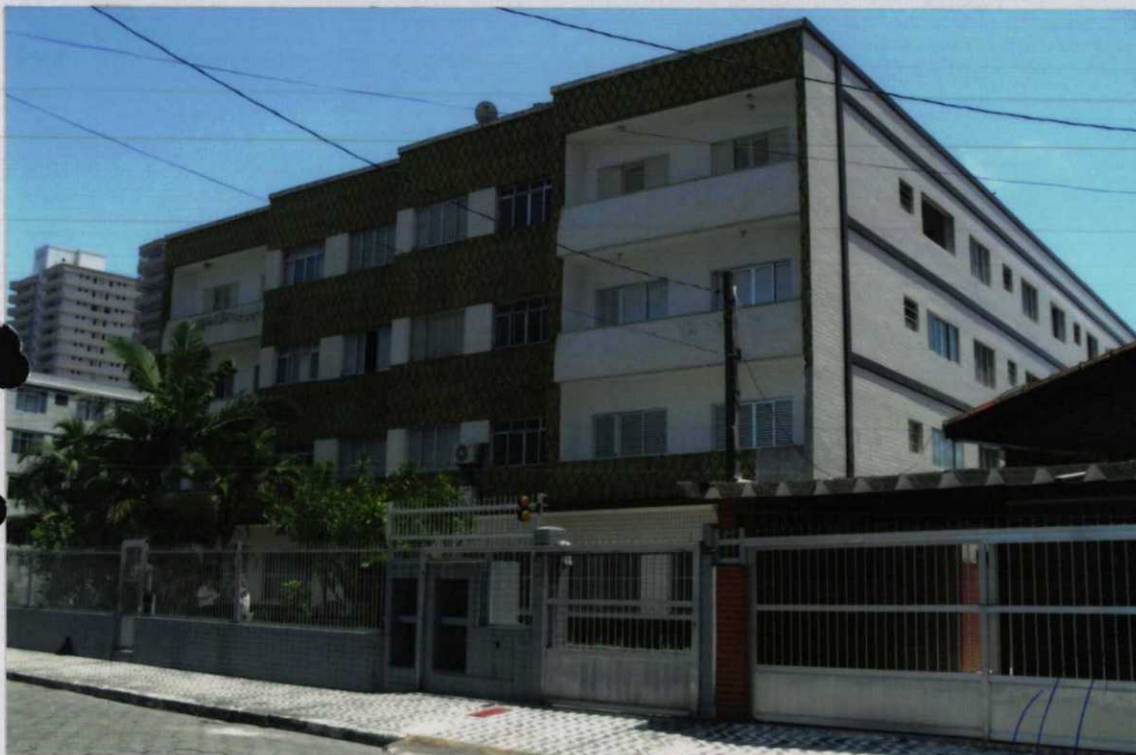
Foto nº 01 – fachada do Edifício Residencial Glória, frente para Rua Pedro Álvares Cabral, com paredes externas revestidas em cerâmica.
