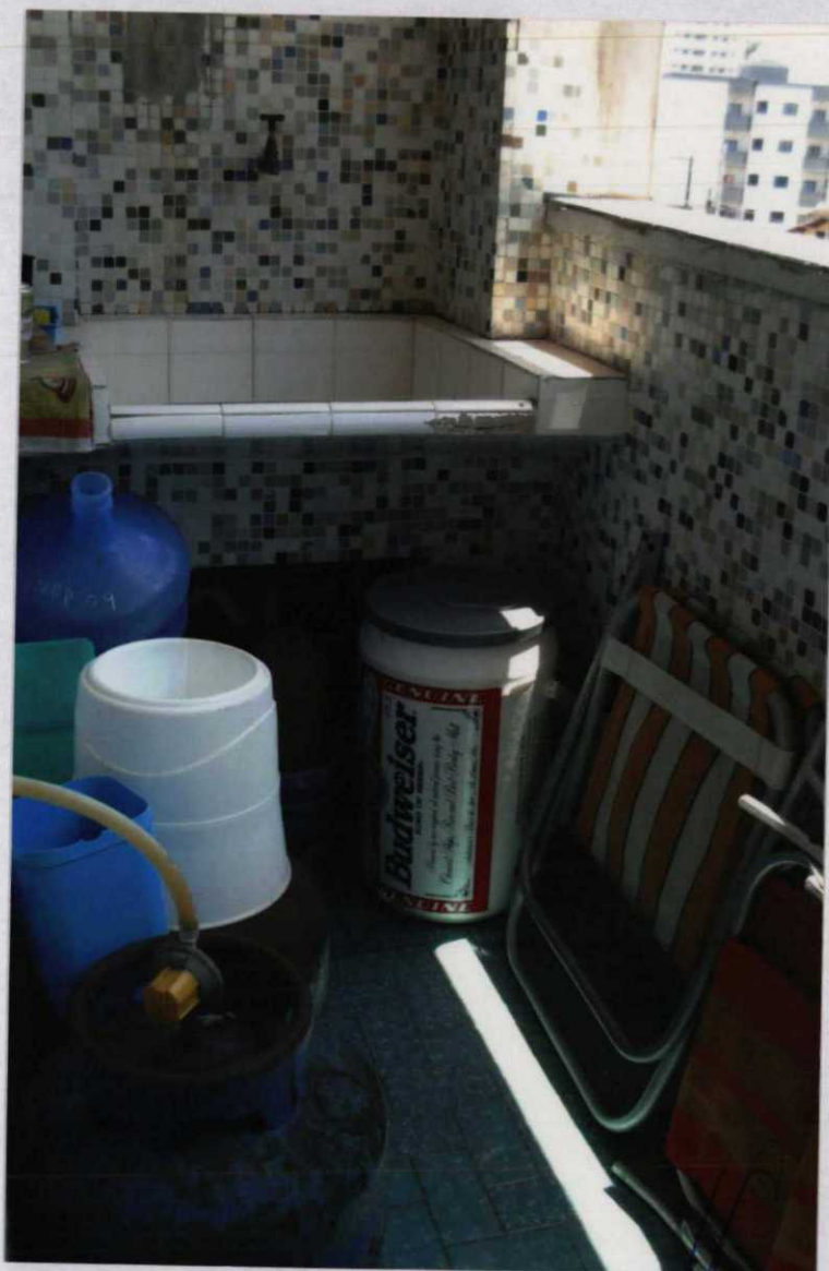
foto nº 20 – área de serviço com piso de cerâmica vitrificada, paredes de pastilha e tanque de lavar de azulejos.
