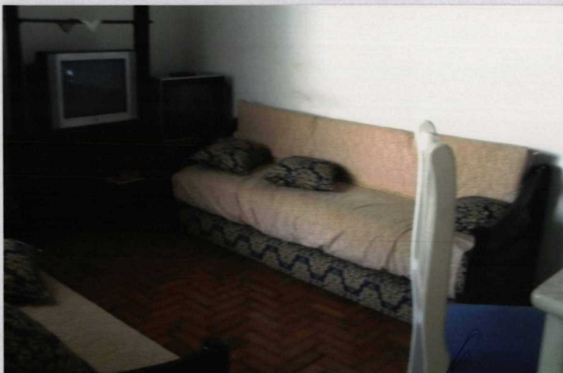
foto nº 14 - interior da sala do apartamento avaliando nº 313, com paredes com massa corrida e látex, e piso de tacos de peroba.
