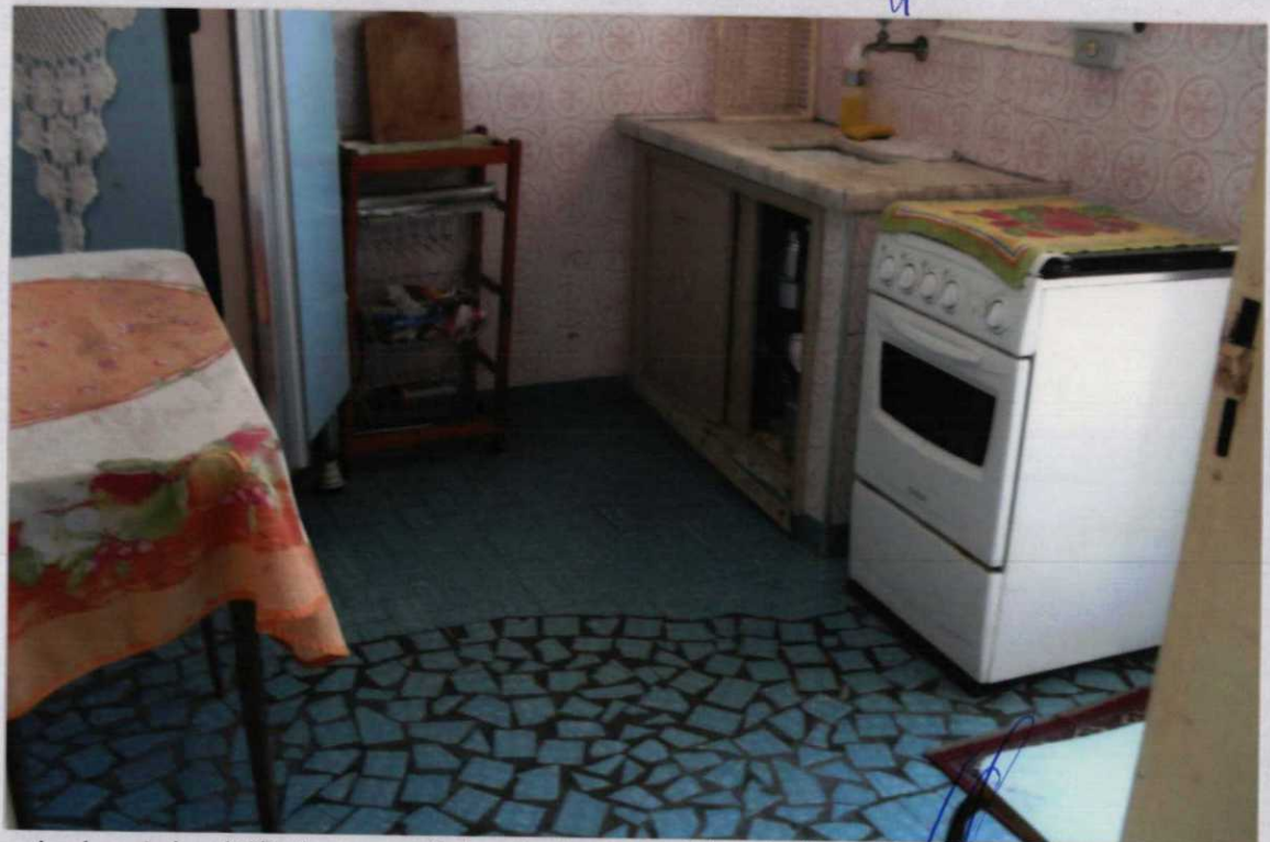
Foto nº 19 - cozinha com piso de cerâmica vitrificada e caco cerâmico, paredes com azulejos coloridos, e pia de ferro com tampo de mármore e armários de madeira.
