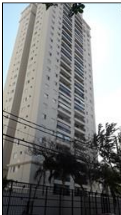
FOTO 02: Vista da Torre 4 onde se localiza o imóvel avaliando.
