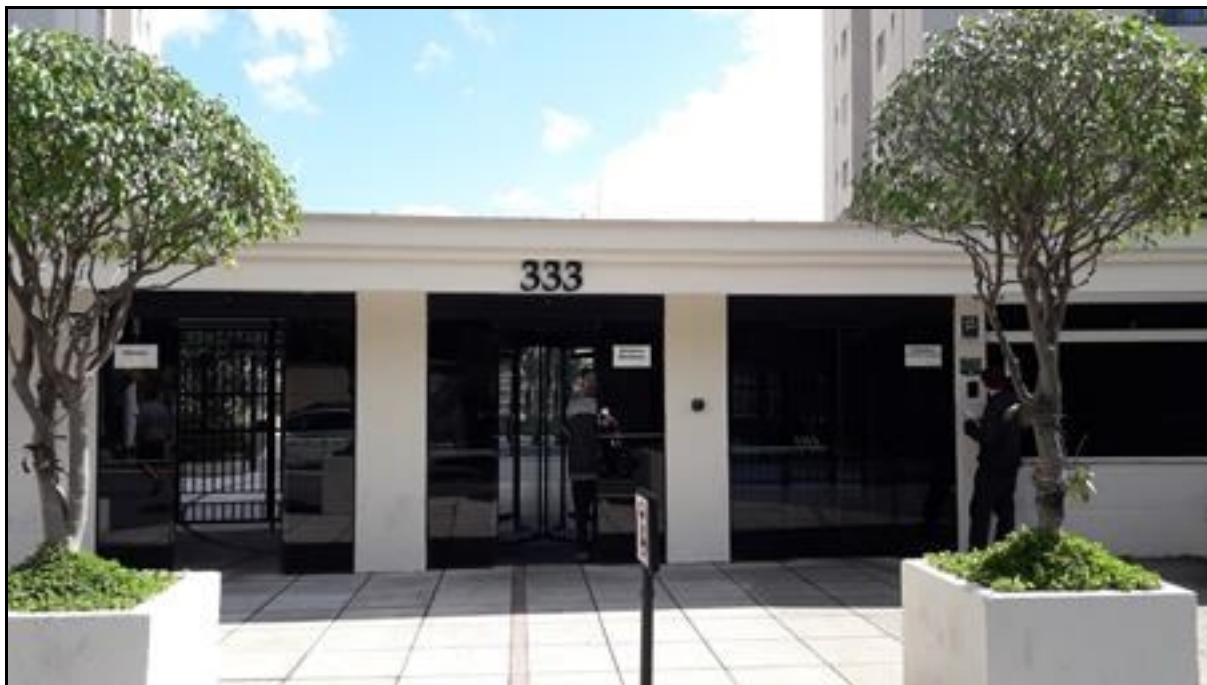
FOTO 01: Vista frontal da portaria principal do Condomínio Vivaz.
