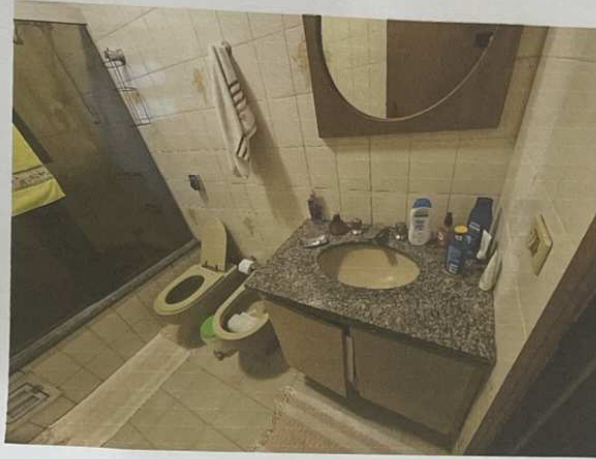
Foto 21 – Vista do banheiro no pavimento superior.
