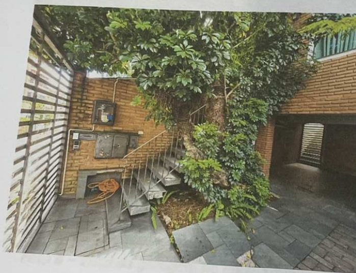
Foto 4 – Vista da área externa do imóvel.
