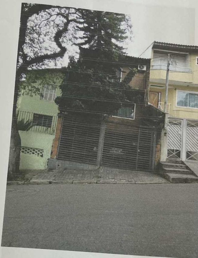
Foto 03 – Vista da fachada do imóvel avaliando, sito à Rua Paschoal Gastaldo n° 346.
