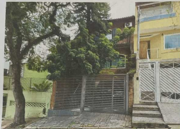
Foto 3 – Vista da fachada do imóvel avaliando, sito à Rua Paschoal Gastaldo n° 346.
