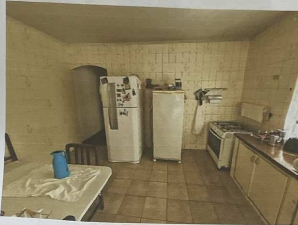
Foto 15 – Vista da cozinha com piso cerâmico, paredes azulejadas até o teto, forro em laje.
