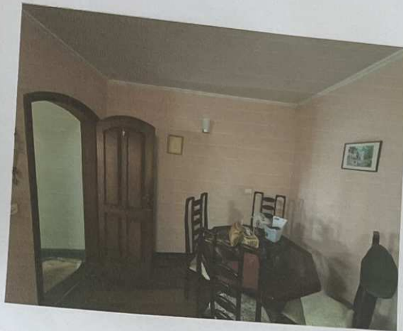
Foto 9 – Vista da sala de jantar com piso em assoalho de madeira, paredes revestidas em massa corrida pintadas em látex e forro em laje.
