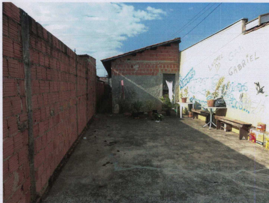
VISTA DO IMÓVEL N° 155 DA RUA LA PAZ
