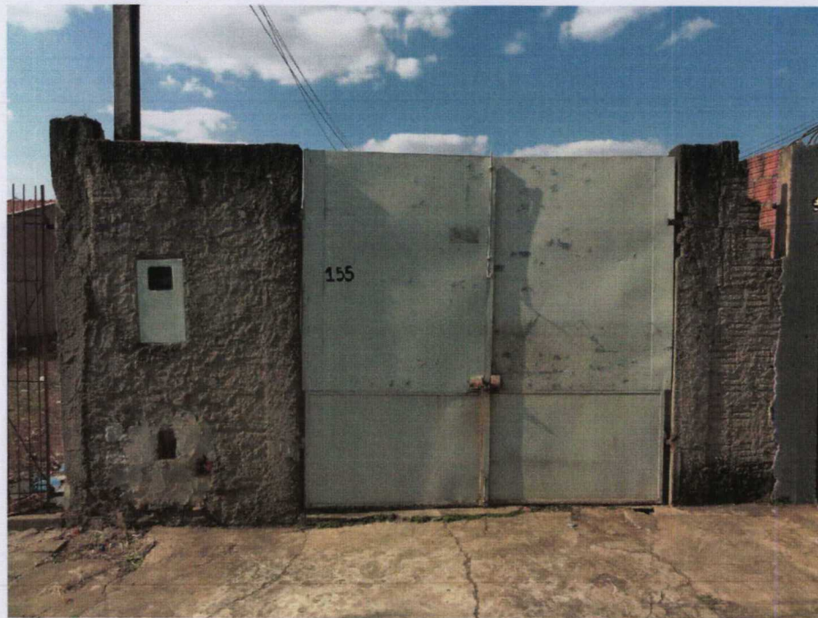
VISTA DA FACHADA DO IMÓVEL N° 155 DA RUA LA PAZ.
