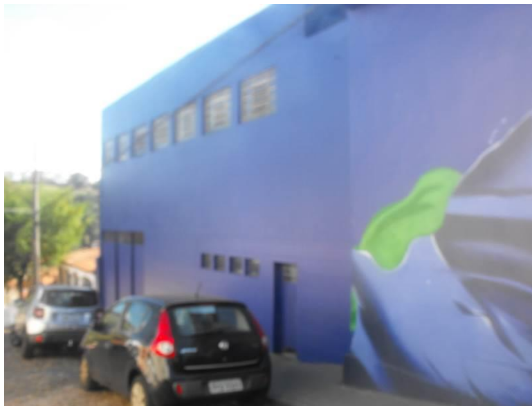
Foto 03 – Mostrando que o prédio em alguns pontos, possuía 03 (três) pavimentos, terreno, superior e porão.
