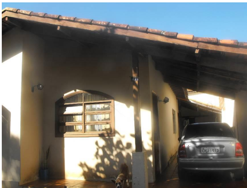
Foto 22 – Mostrando outra parte da fachada da residência.
