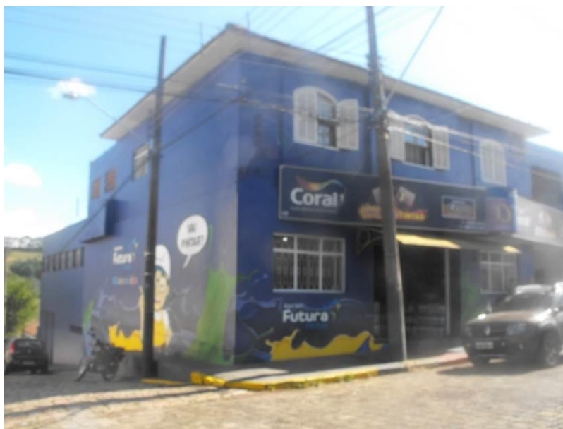
Foto 02 – Mostrando uma visão geral das fachadas do prédio.
