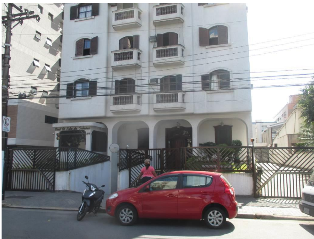
Acima, temos uma tomada da entrada do “Condomínio Edifício Solar dos Sobreiras” em questão.
