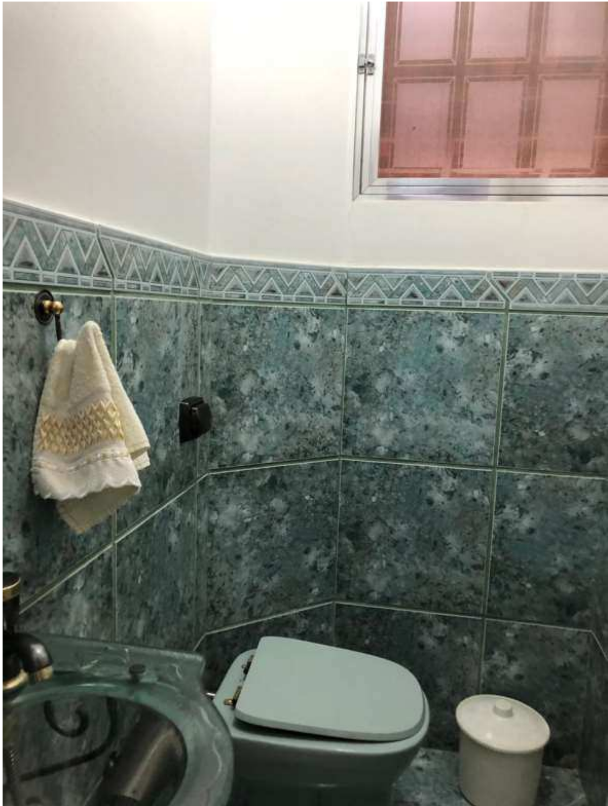
FOTO 22 - VISTA GERAL DO LAVABO DO PAVIMENTO TÉRREO.
