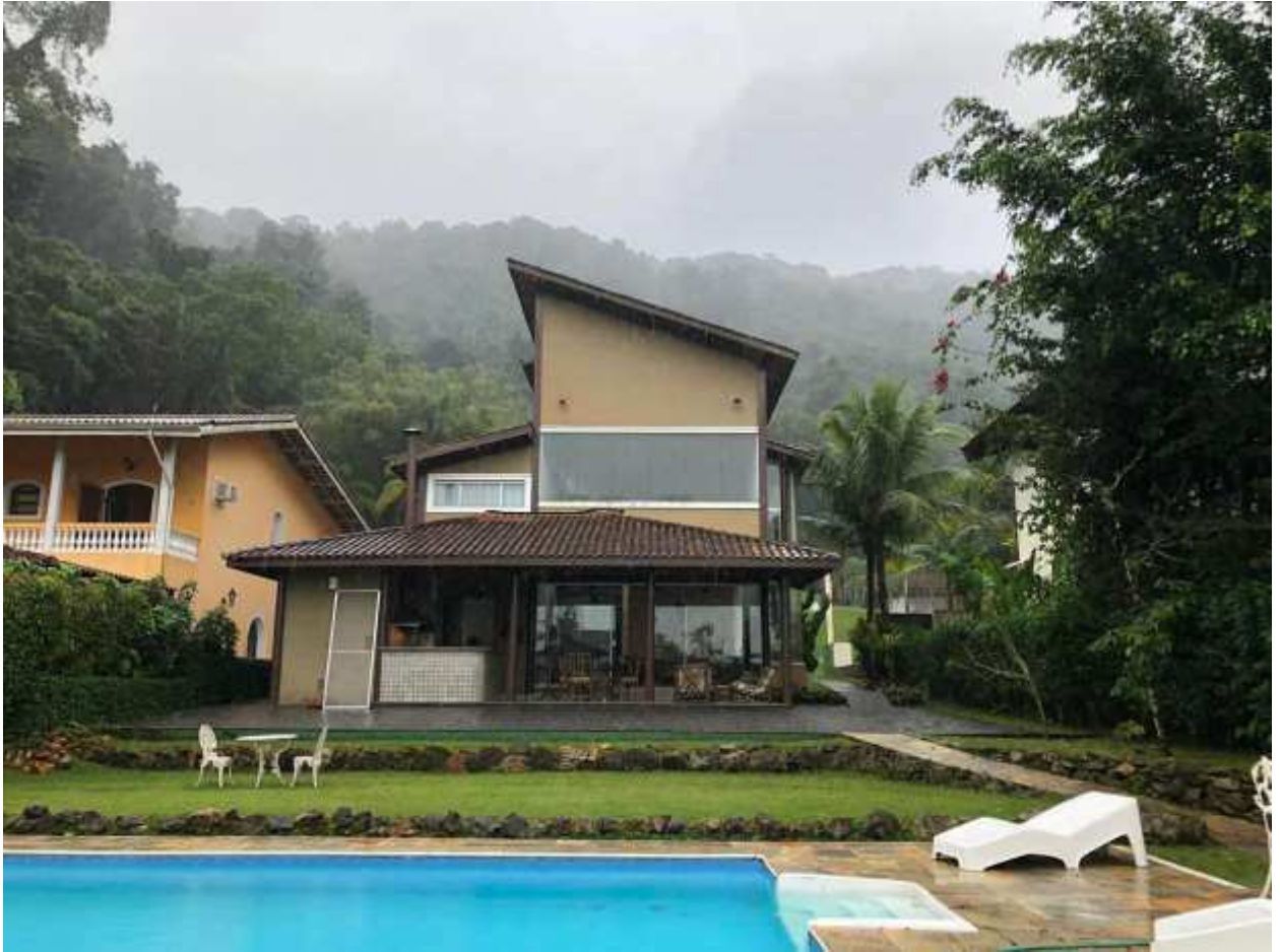
FOTO 7 - VISTA GERAL DOS FUNDOS DO IMÓVEL.
