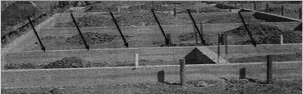
Esse tipo de viga pode funcionar como a própria fundação do imóvel. Em terrenos firmes e construções pequenas, ela é destinada a suportar a carga de todas as paredes de uma construção, transferindo essa carga às brocas e estacas ao solo<sup>2</sup>.
