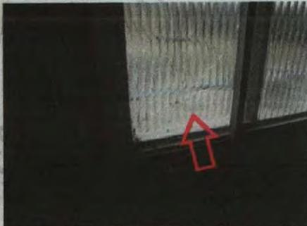
Foto 06 - Banheiro social: vista parcial do banheiro; Foto 07 - Idem: 2 vidros da janela basculante quebrados; Foto 08 - Quarto frontal: 1 vidro da janela quebrado;
