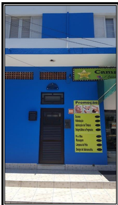
Figura 5 – Entrada do Edifício
